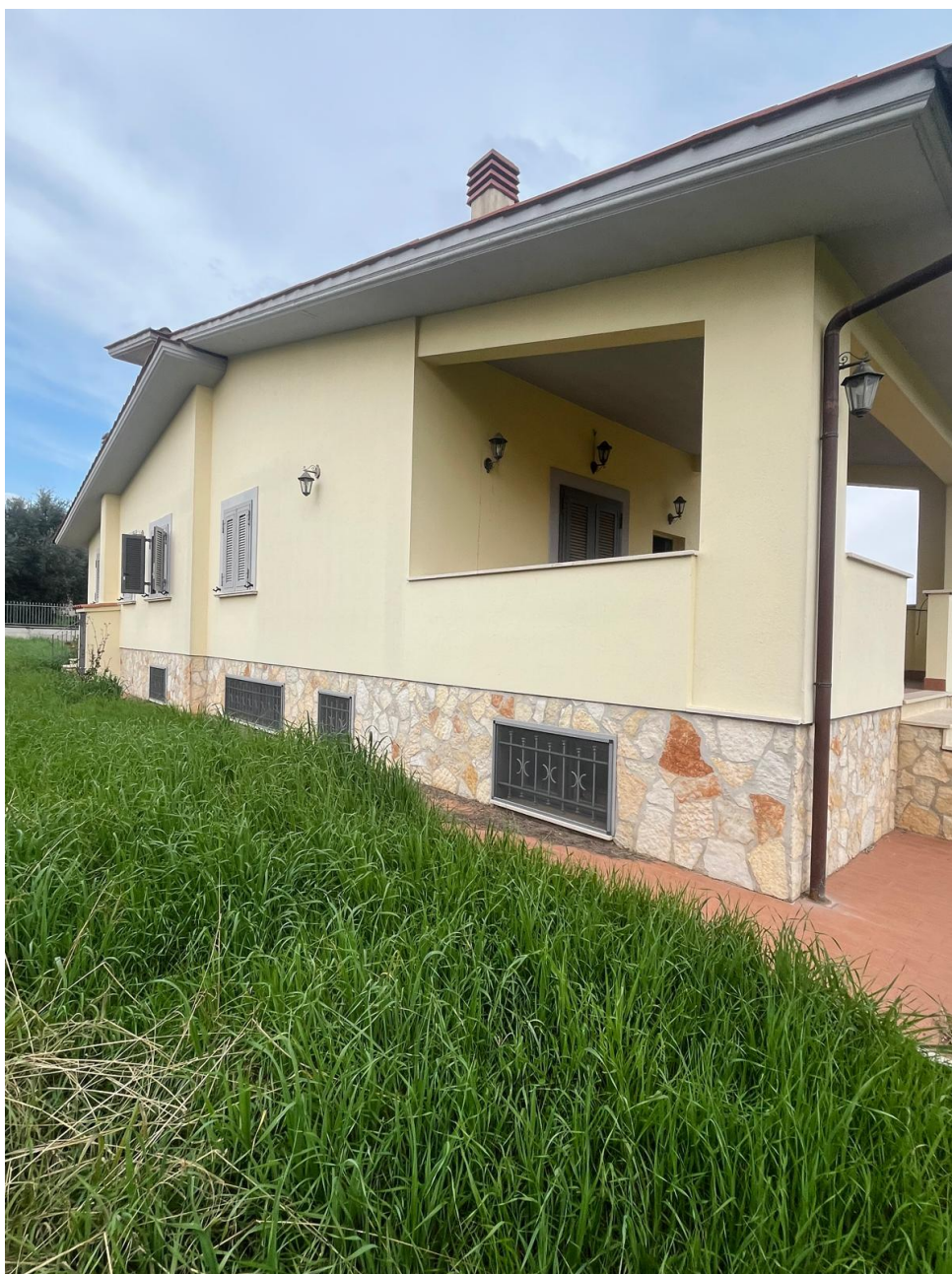
Foto n. 1 – Prospetto del fabbricato
