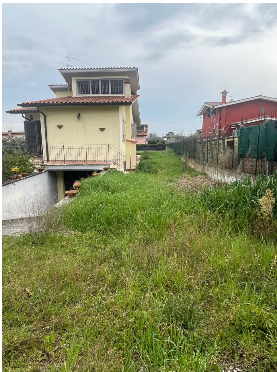
Foto n. 2 – Prospetto del fabbricato
