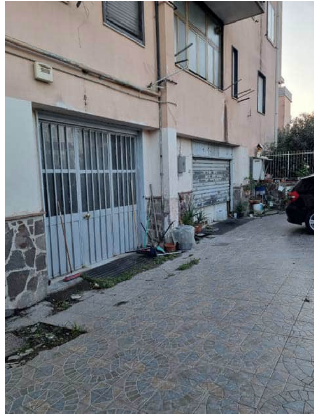
Foto 2 – Ingresso ai locali dalla corte
