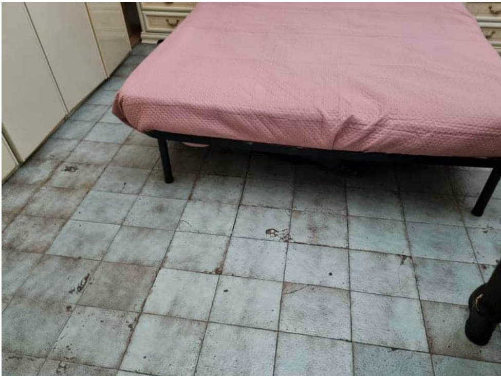
Foto 5 – Camera 1, in evidenza la pavimentazione
