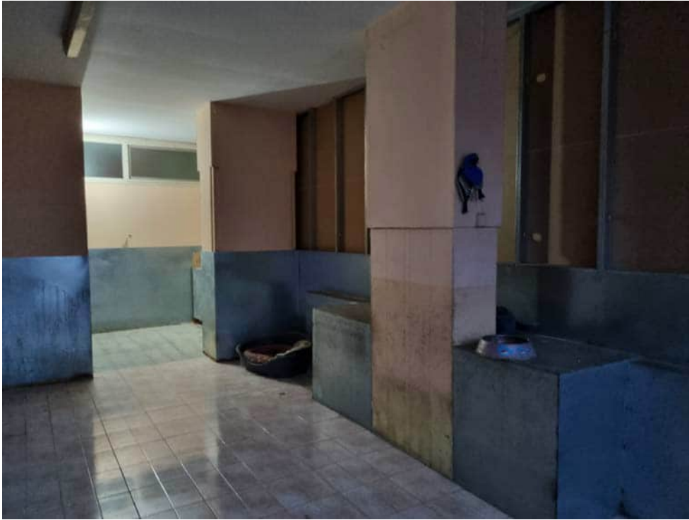
Foto 10 – Camera 5 di accesso alla camera 6
