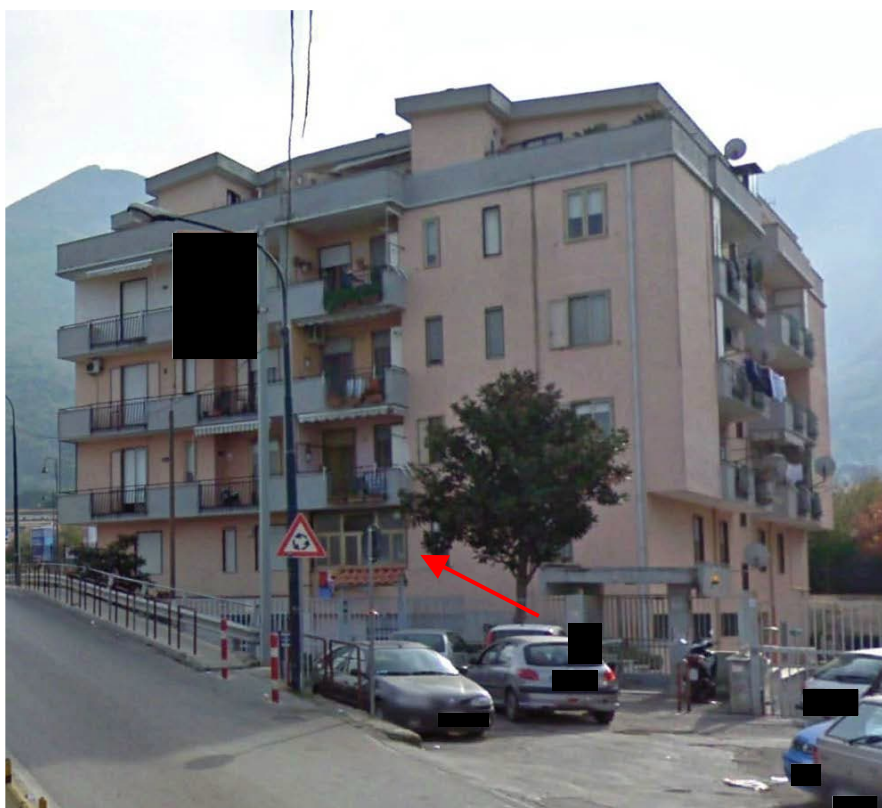
Fabbricato di n.6 piani che contiene il bene staggito In evidenza l'accesso al bene
