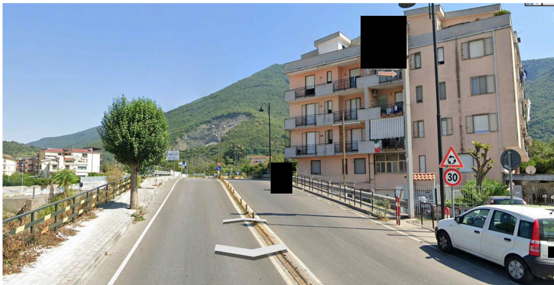
Vista del fabbricato da Via Tramontano
