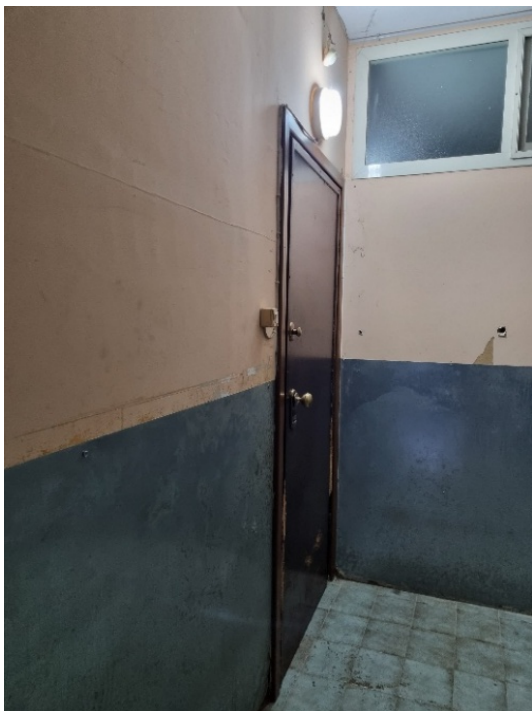
Accesso alla camera 6 da altra unità immobiliare - PUNTO 2
