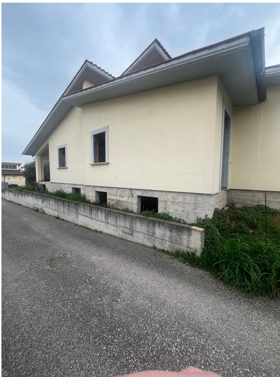
Foto n. 1 – Prospetto del fabbricato
