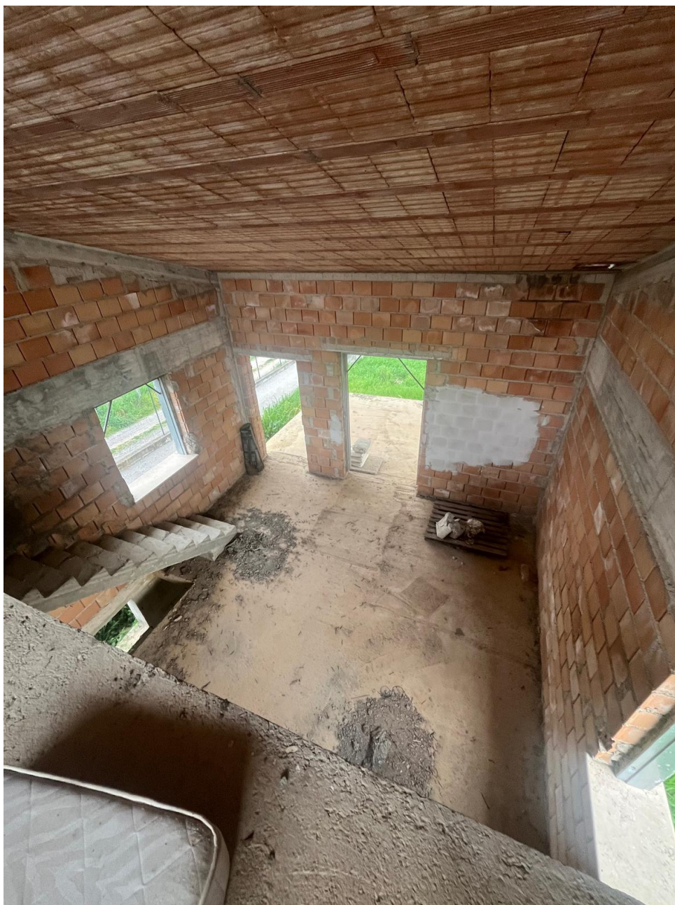
Foto n. 9 – Piano primo, vista sul piano terra
