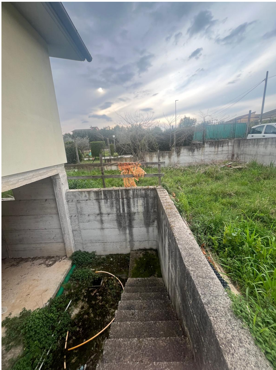
Foto n. 3 – rampa piano seminterrato
