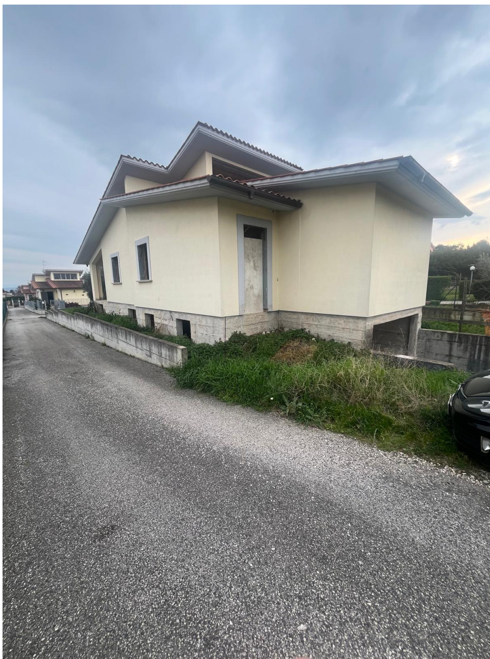
Foto n. 2 – Prospetto del fabbricato
