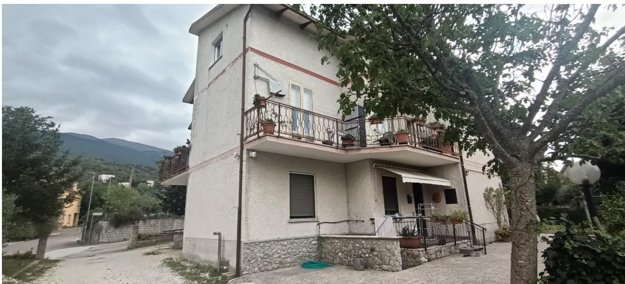
Foto n.2: particolare dei prospetti nord e ovest e della corte comune.
