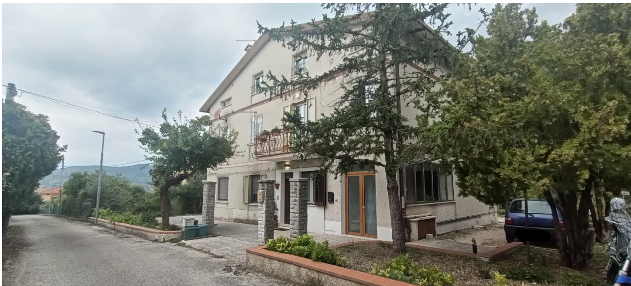
Foto n.4: veduta dei prospetti sud (in primo piano) e est del fabbricato e di parte della corte comune dotata di altro accesso sempre da via Monte Nero. È visibile il portoncino in legno e vetro di ingresso al portico da cui si diparte il vano scala comune ai piani primo e secondo sottotetto.
