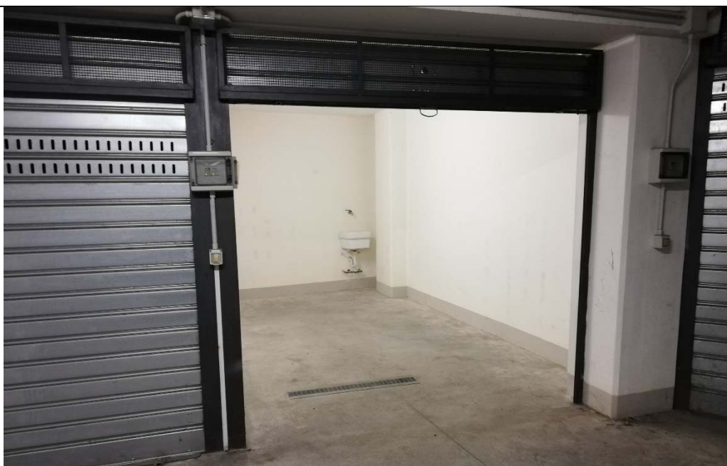
Vista esterna box
