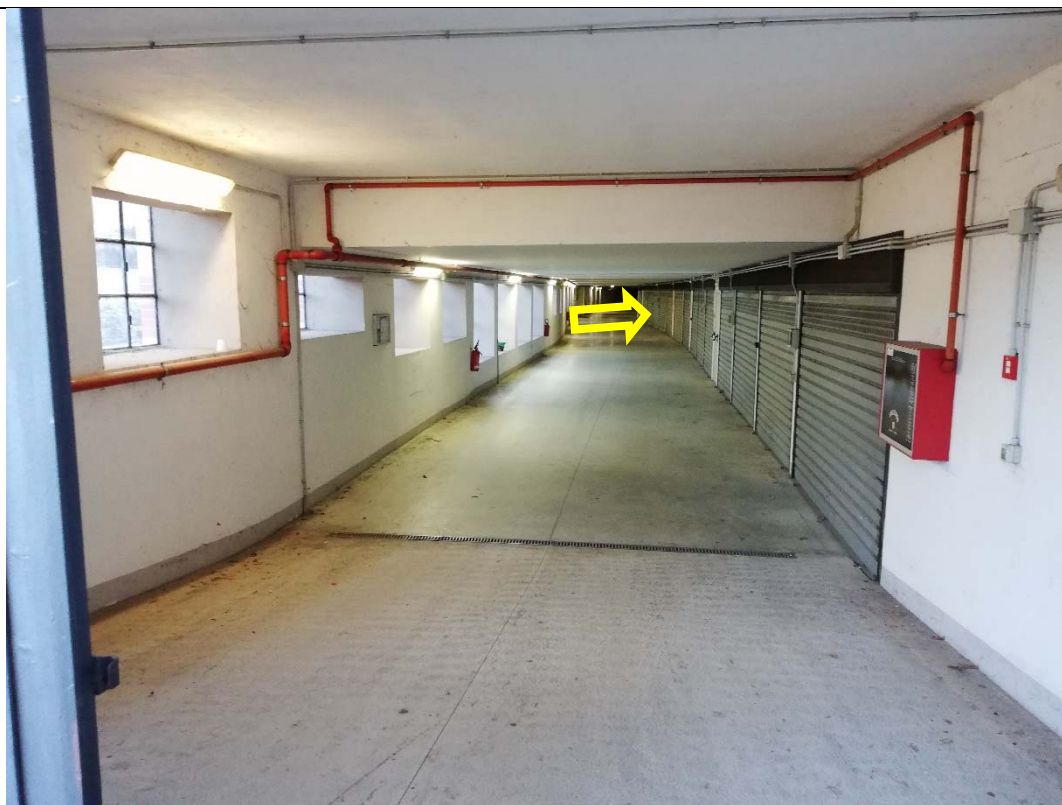
Corsia di manovra principale
