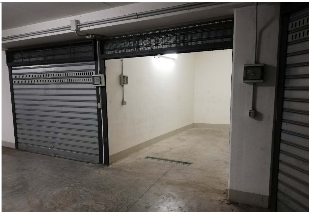
Vista esterna box
