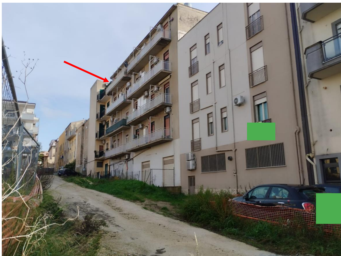
Foto 3 – Veduta dell'appartamento posto al quarto piano
