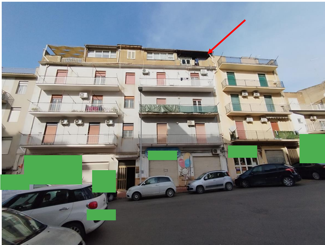
Foto 4 – Veduta dell'appartamento da via Senatore Sammartino
