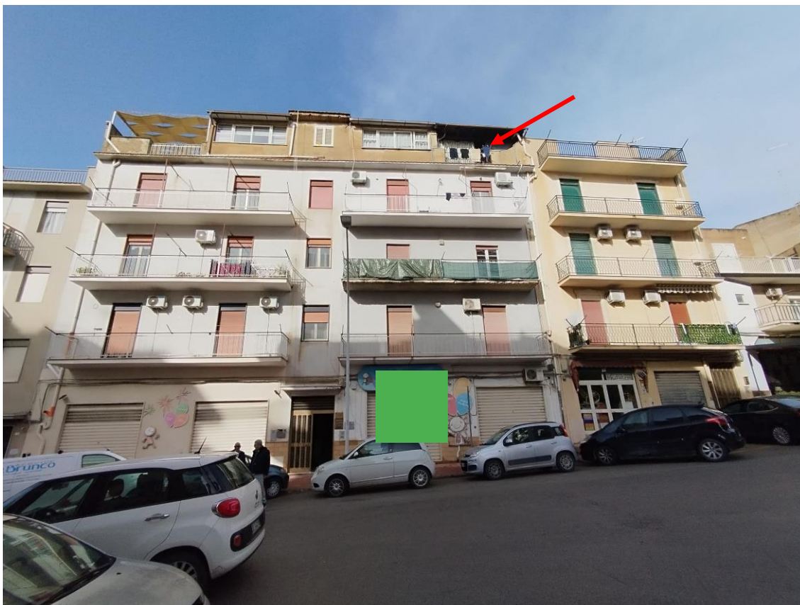
FOTO 4 – VEDUTA DELL'APPARTAMENTO DA VIA SENATORE SAMMARTINO
