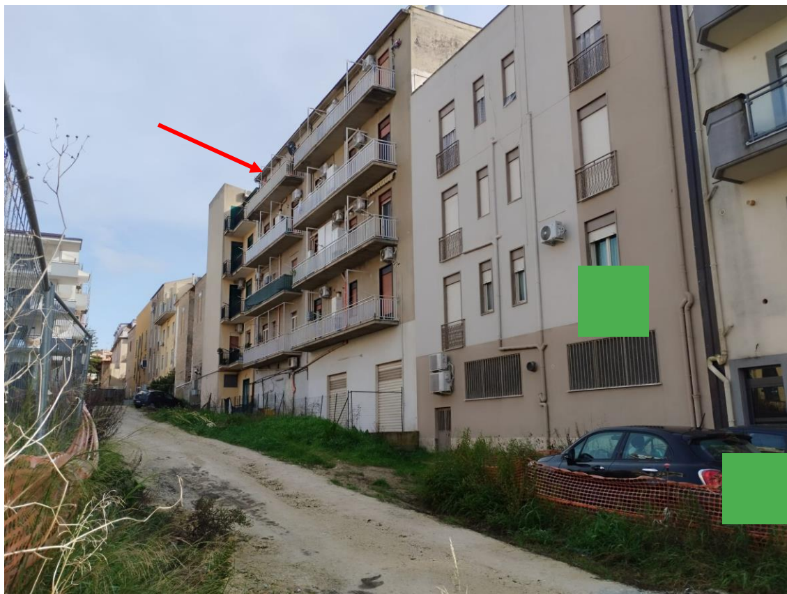
FOTO 3 – VEDUTA DELL'APPARTAMENTO POSTO AL QUARTO PIANO
