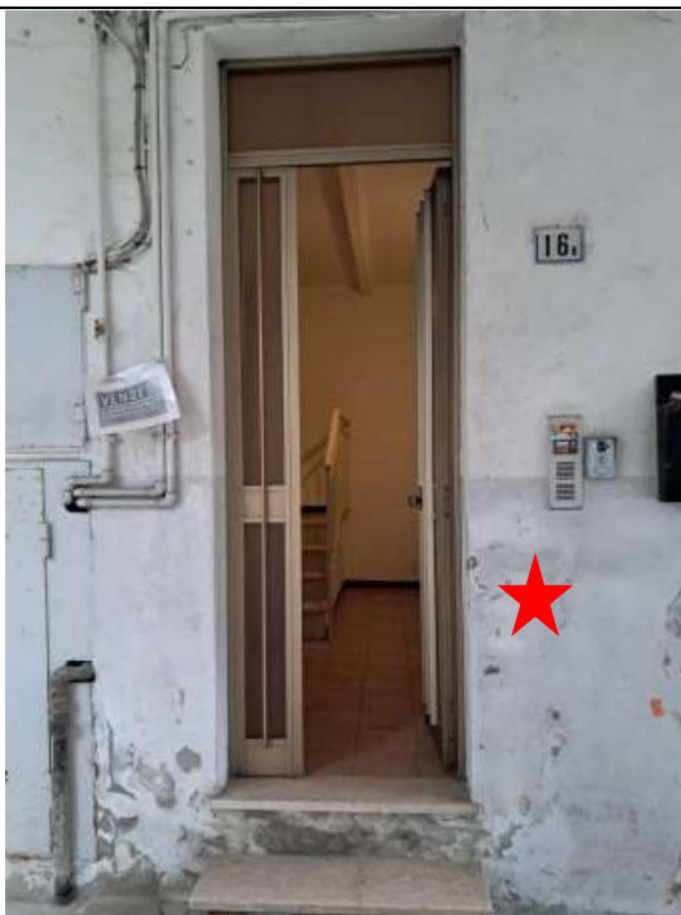
VISTA ESTERNA CIVICO 16/B
