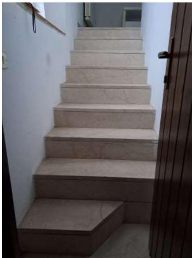
VANO SCALA INTERNO VERSO IL SOGGIORNO
