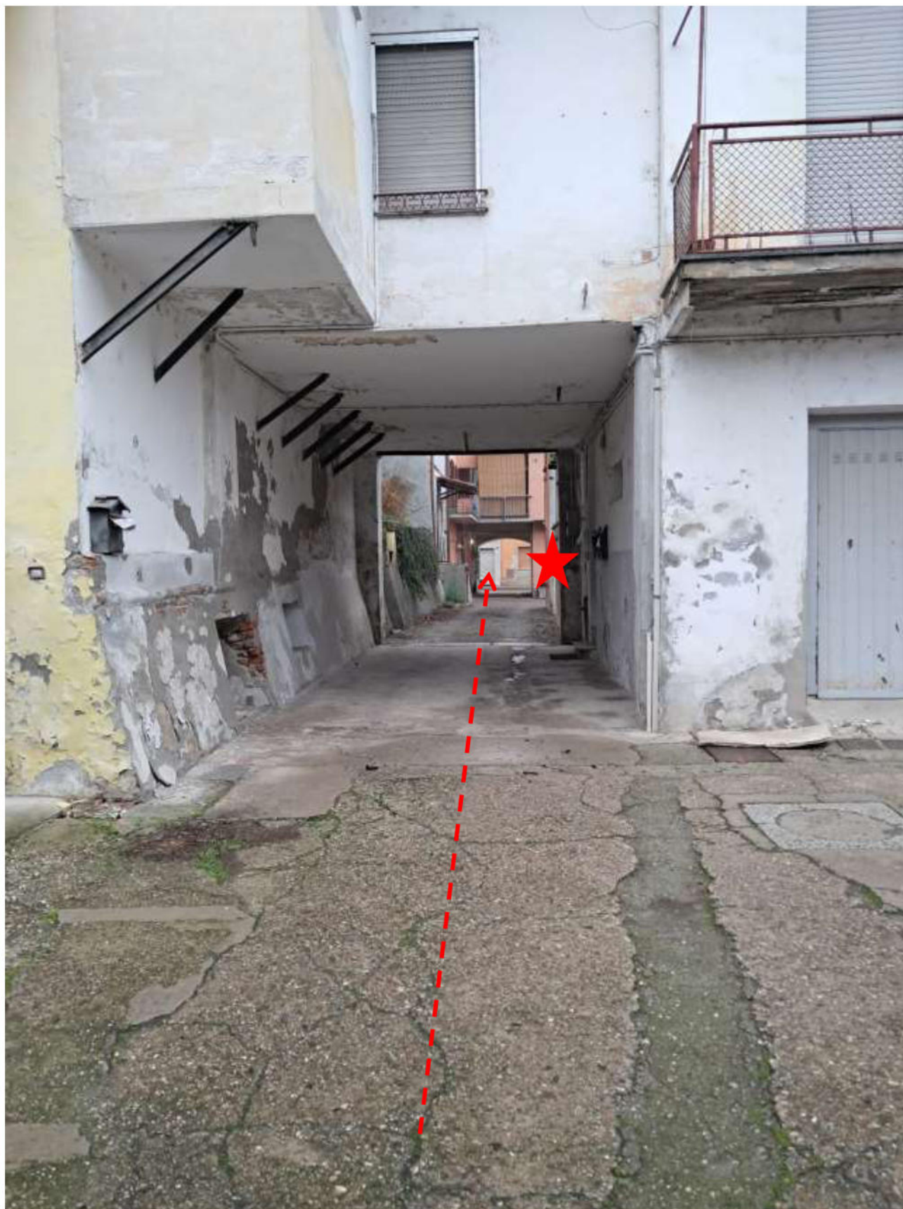
VISTA DAL CORTILE VERSO LA PUBBLICA VIA
