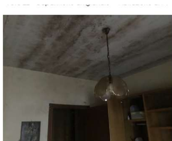
Foto 24 – Particolare soffitto dell'abitazione al P1
