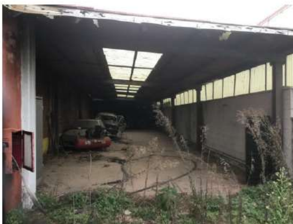
Foto 5- Capannone artigianale – Tettoia lato sud
