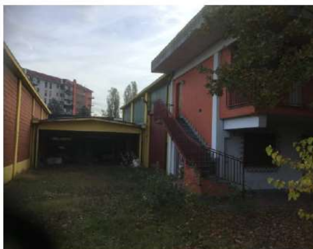
Foto 2 – Capannone artigianale – Lato nord
