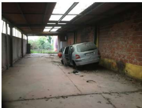
Foto 6- Capannone artigianale – Tettoia lato sud
