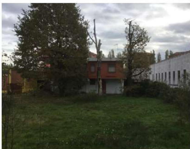
Foto 1 – Capannone artigianale –Lato ovest
