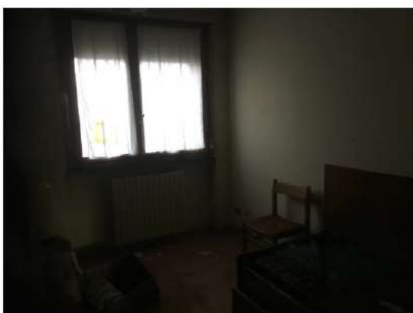
Foto 21 - Capannone artigianale – Abitazione al P1
