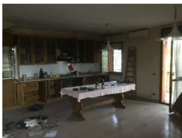
Foto 16 - Capannone artigianale – Abitazione al P1
