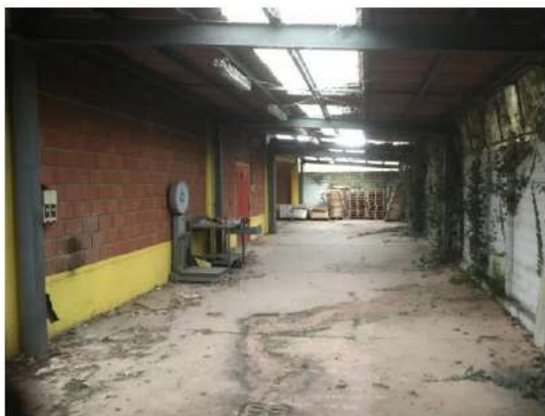
Foto 7- Capannone artigianale – Tettoia lato est
