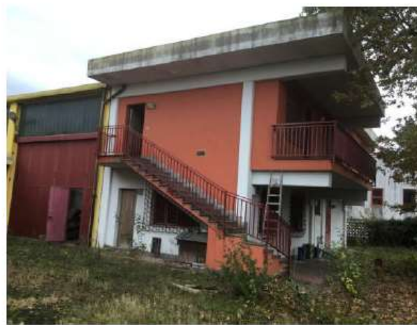
Foto 4 – Capannone artigianale – Lato nord
