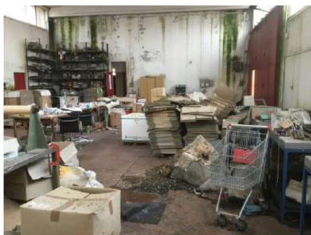
Foto 9- Interno capannone – Parete ovest-nord
