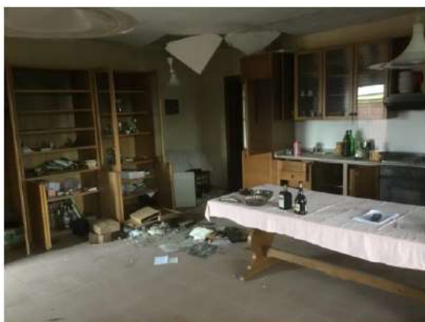
Foto 17 - Capannone artigianale – Abitazione al P1
