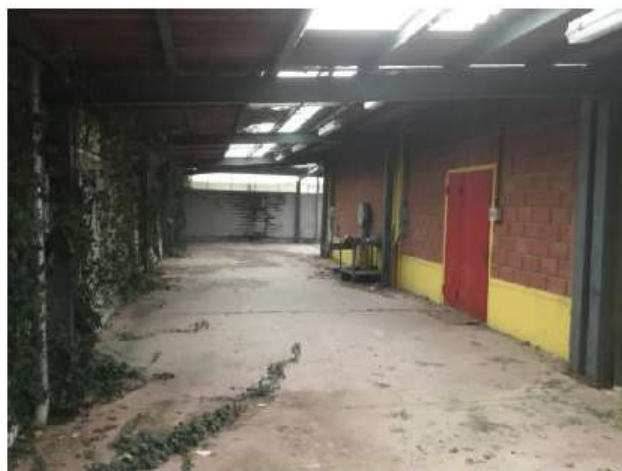
Foto 8 Capannone artigianale – Tettoia lato est
