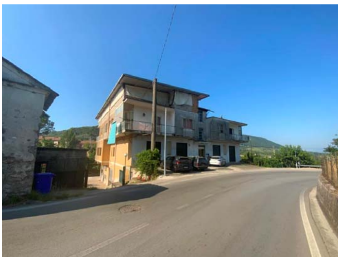
Vista da Nord-Est, dalla S.P.26d
