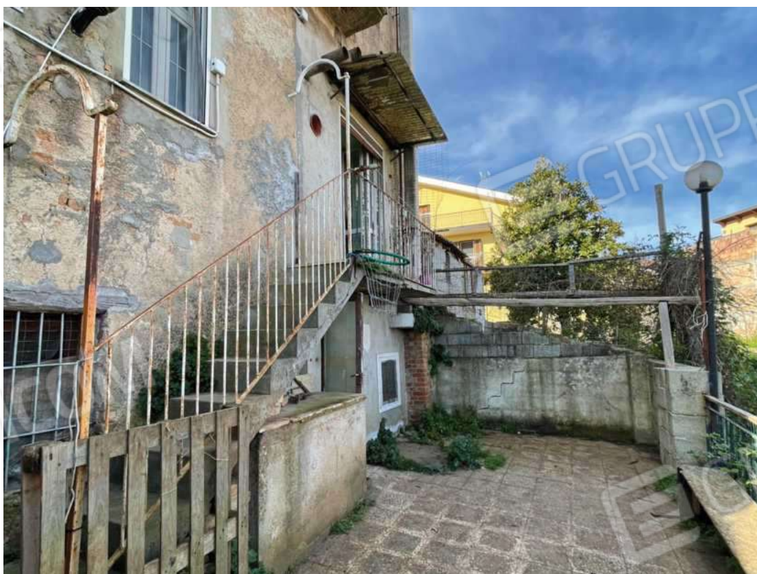
Foto 10 N.C.E.U. Sant'Onofrio fg. 6 - p.lla 724 sub 2 cortile
