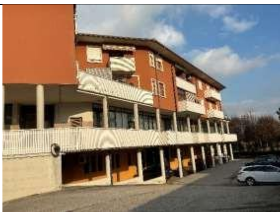
Foto 1: Esterno fabbricato Monte Pasubio
