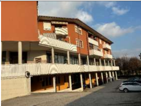
Foto 1: Esterno fabbricato Monte Pasubio
