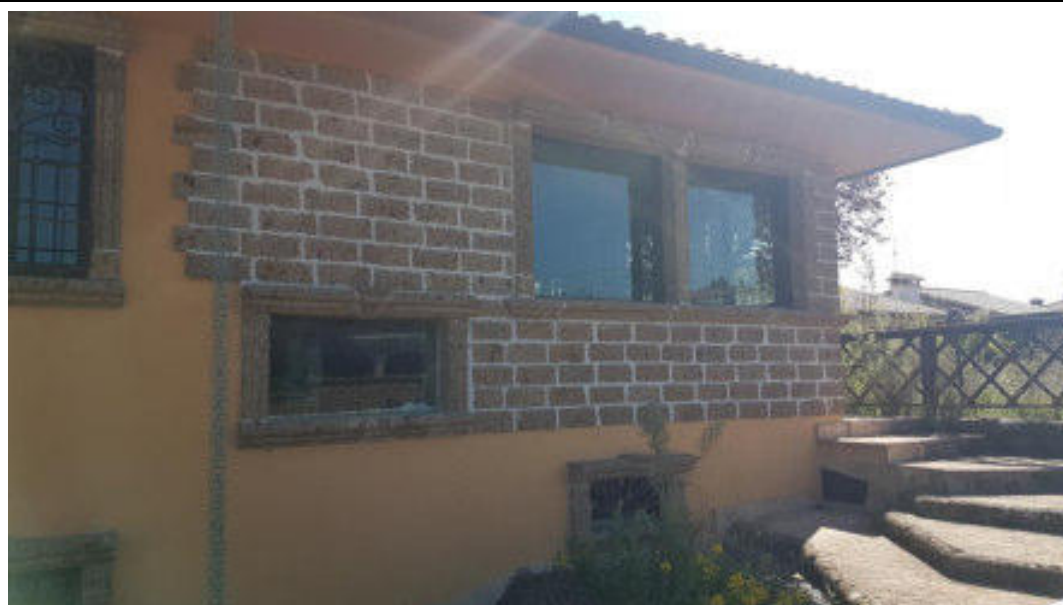
Vista accesso esterno al piano terra
