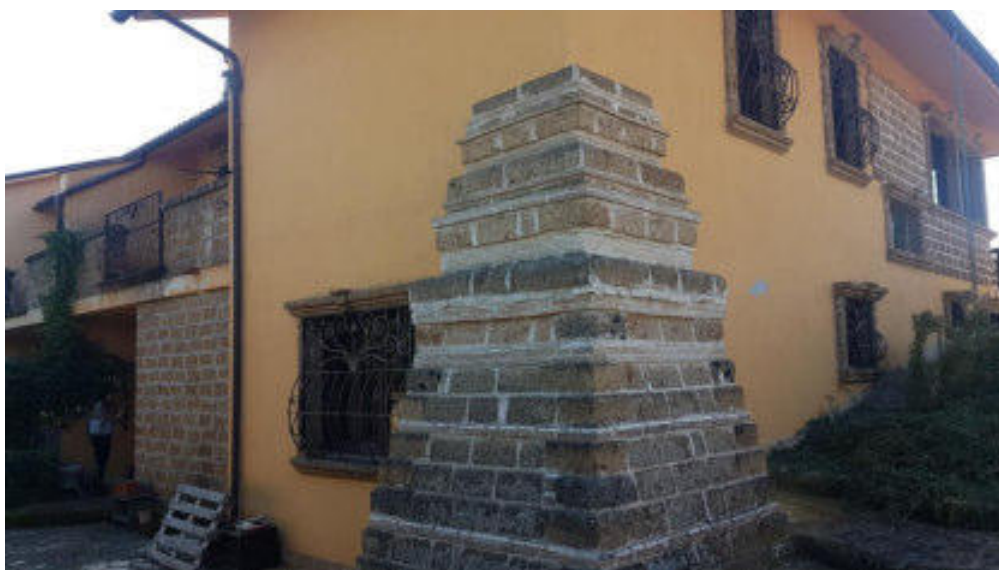
Vista prospetto nord-ovest
