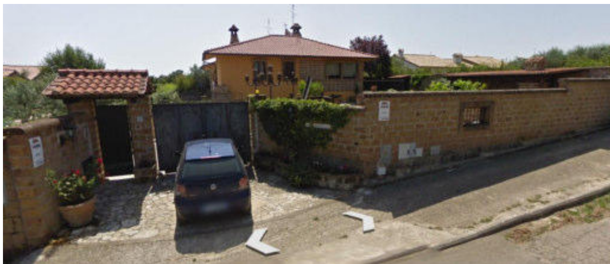
Vista esterna della villa
