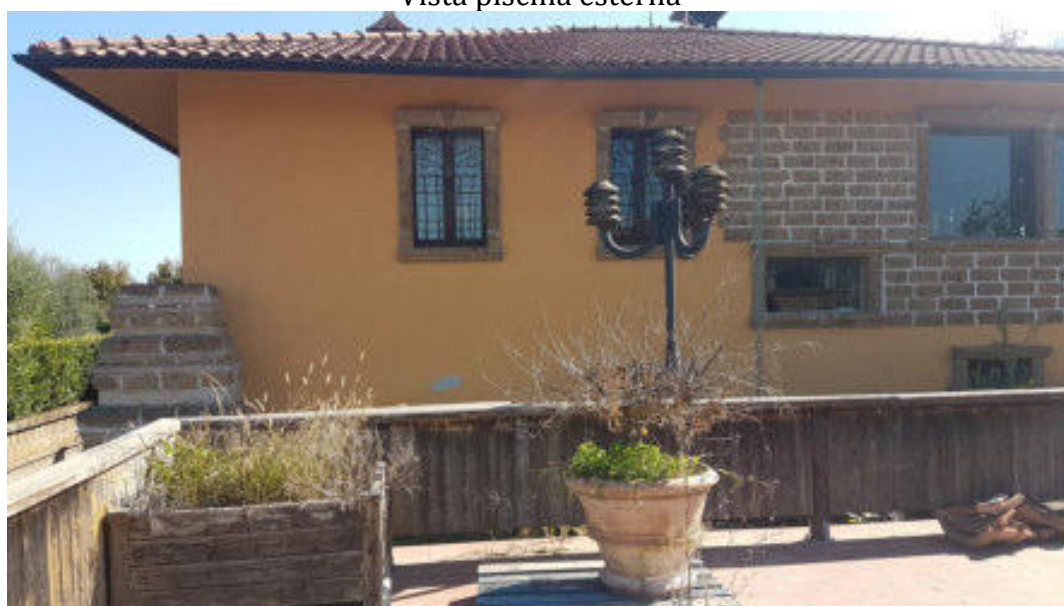
Vista prospetto ovest
