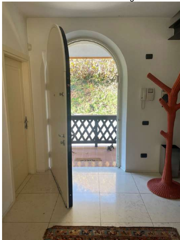
Foto n. 6 – Portoncino blindato ingresso al PT
