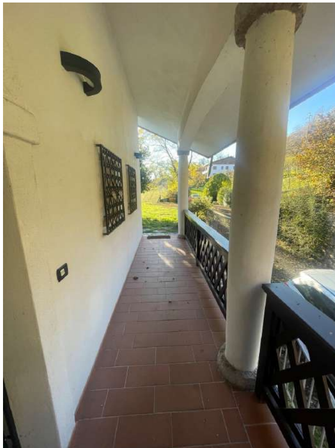
Foto 31 – Porticato sul lato Nord al PT della villa
