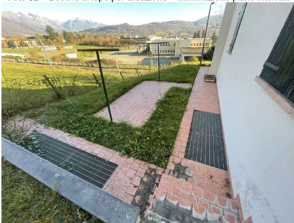
Foto 32 – Bocche di lupo per areazione – illuminazione piano interrato
