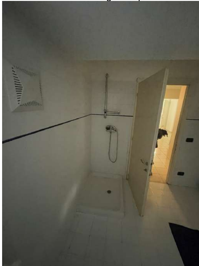
Foto 29 – Doccia nel bagno al piano interrato
