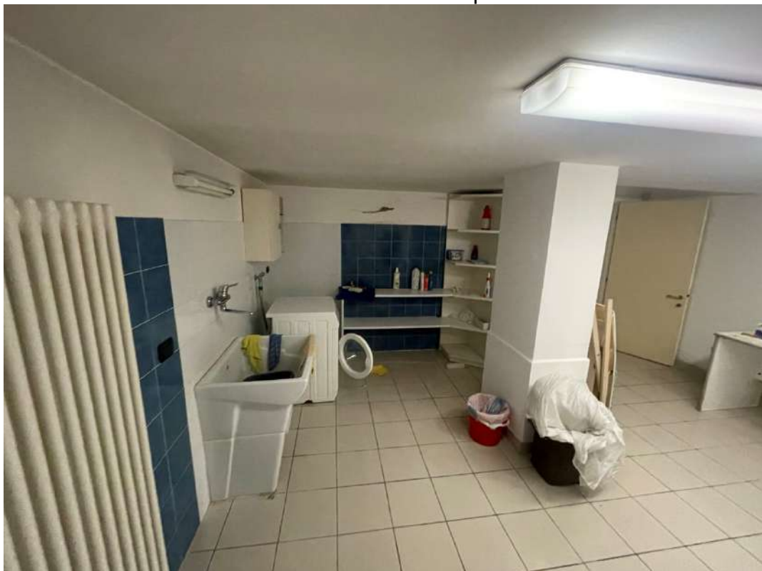
Foto 28 – Locale lavanderia nel piano interrato
