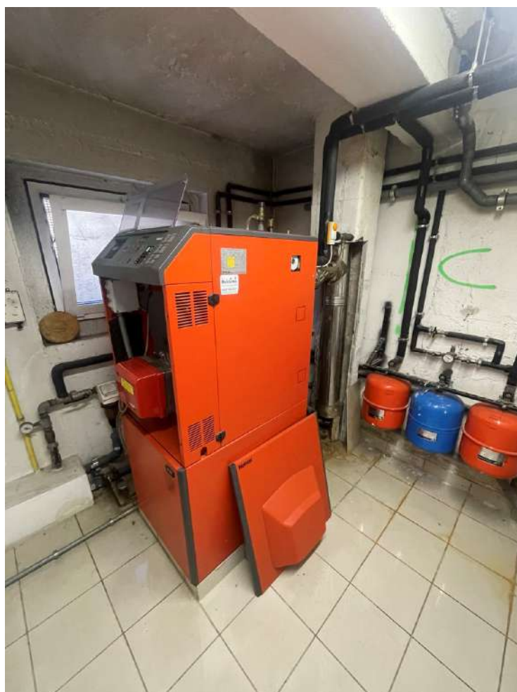
Foto 22 – Caldaia alimentata a gasolio (PS1)
