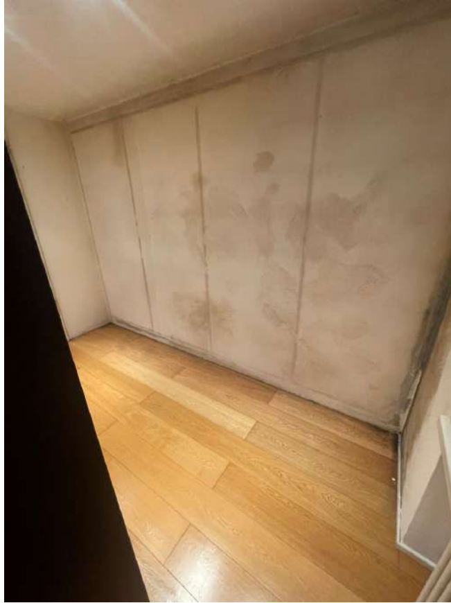
Foto n. 13 Stanza cabina armadio al PT
