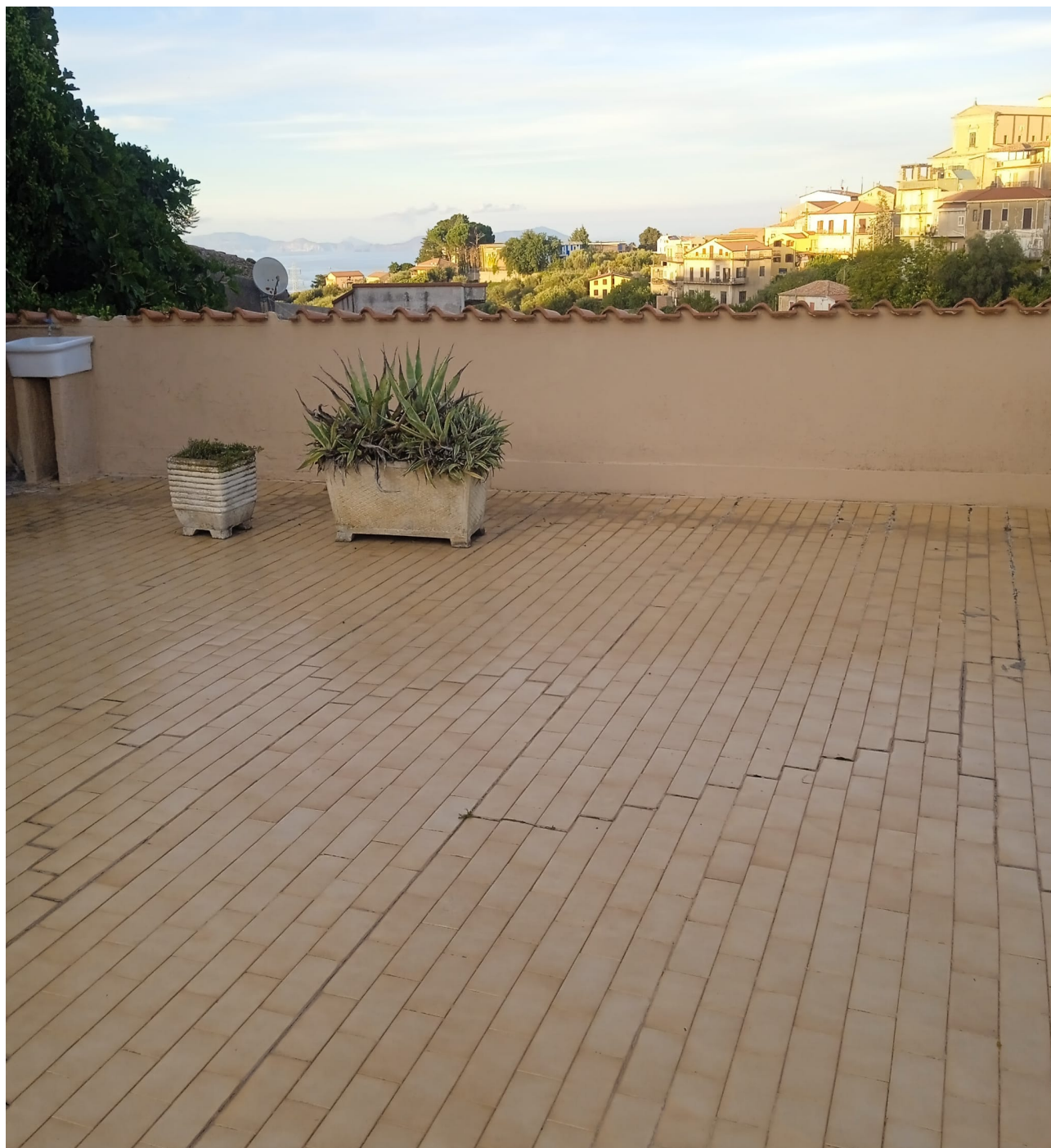
Foto n. 21 terrazza 3 piano terrazza appartamento Via delle Grazie 25 Particella 73
