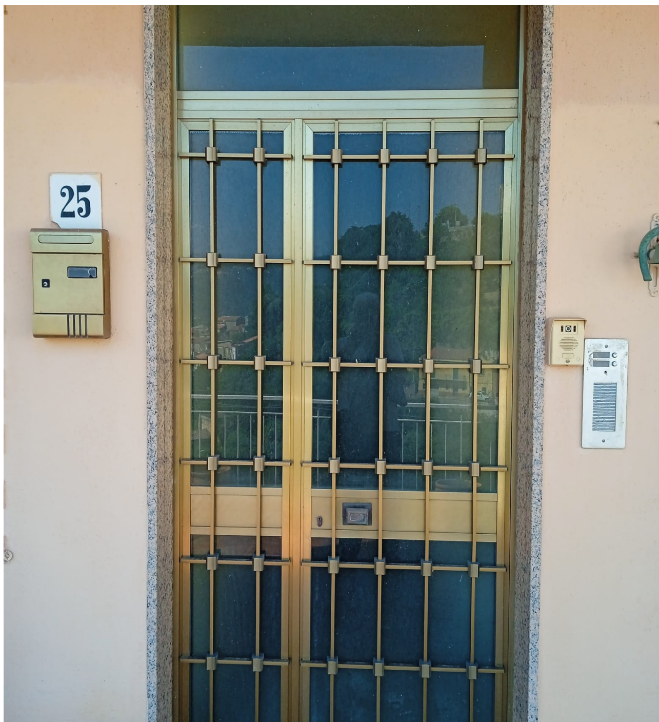
Foto n. 10 Portone ingresso appartamento piano terra Via delle Grazie n. 25 Particella 73
