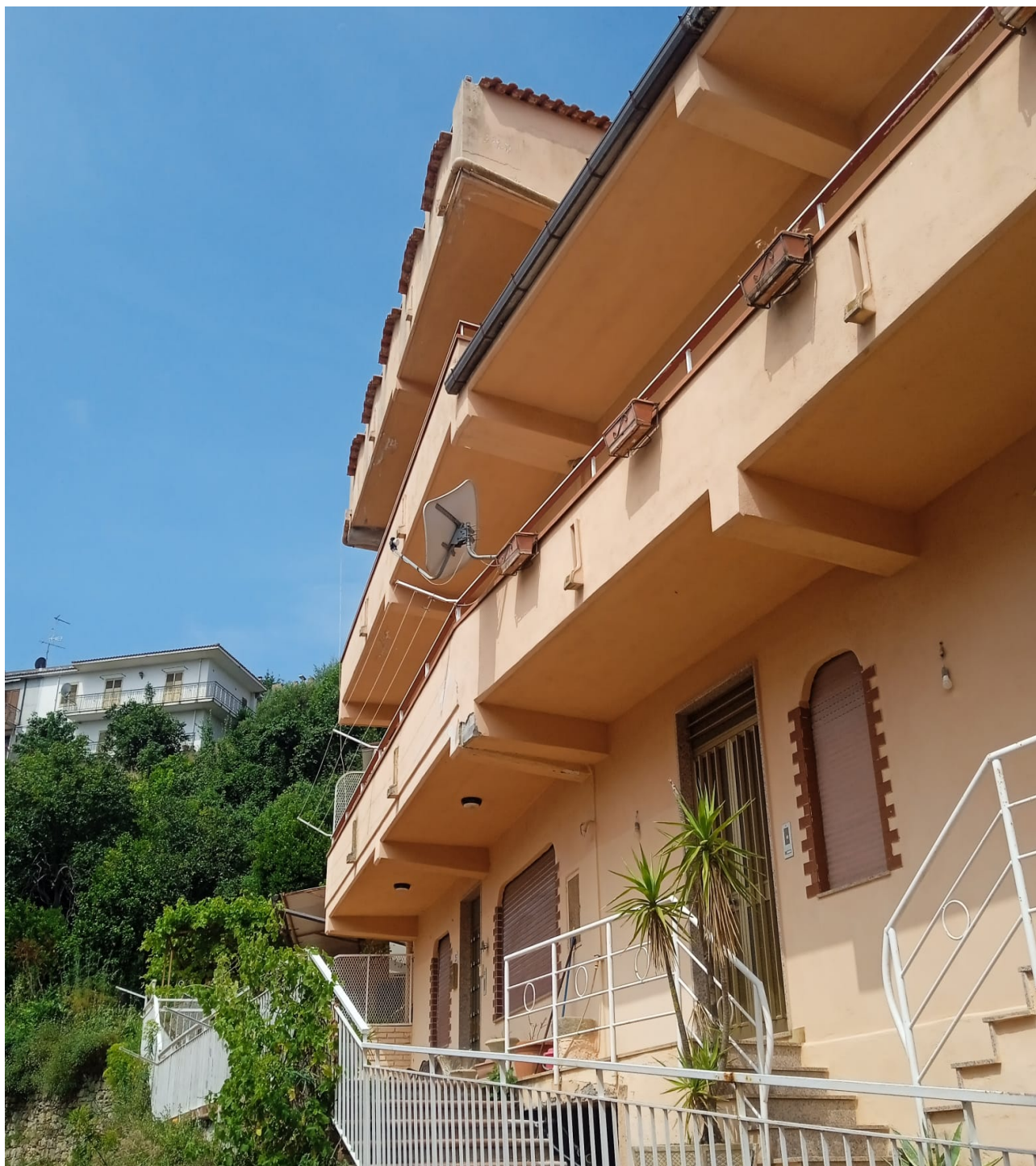
Foto n. 1 Lato esterno parete nord e ingresso dalla Via delle Grazie n.31 Appartamento foglio 17 particella sub 4
