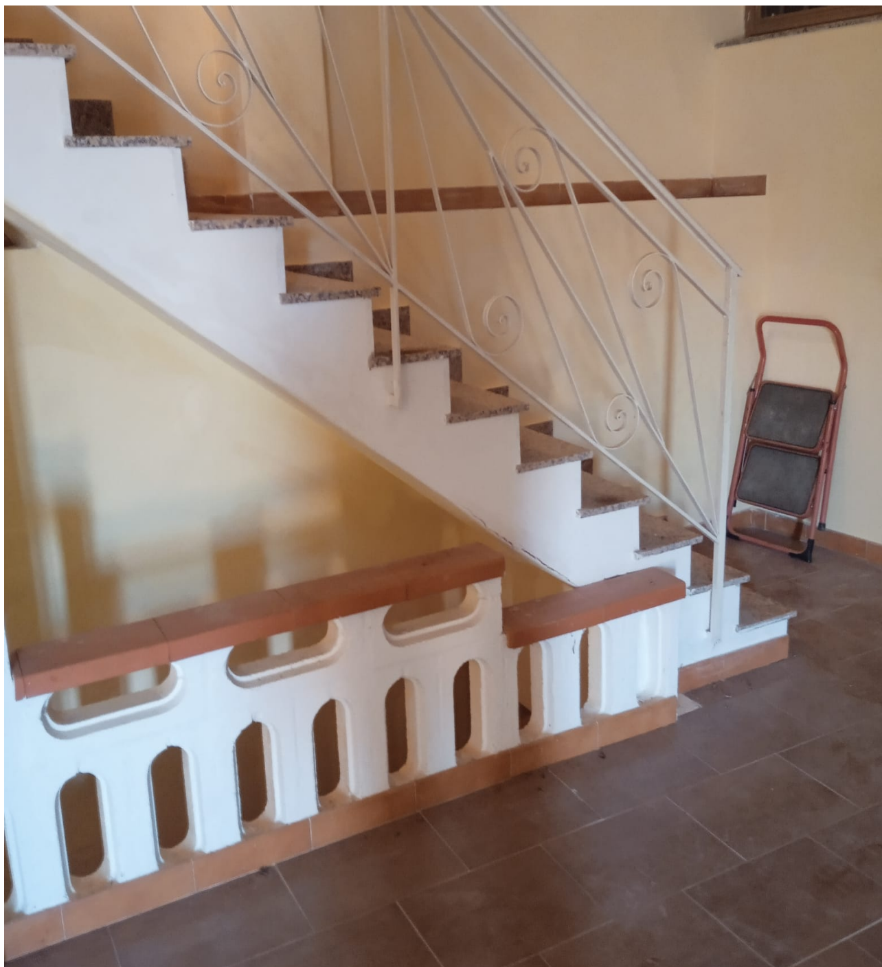
Foto n. 20 Scala di accesso al 3 piano terrazza appartamento Via delle Grazie 25 Particella 73
