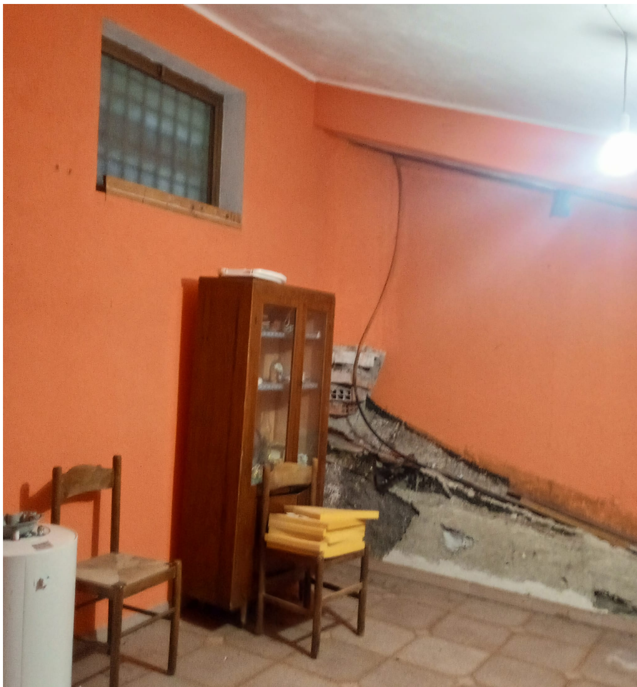
Foto n. 9 Sottotetto appartamento particella 71 sub 4
