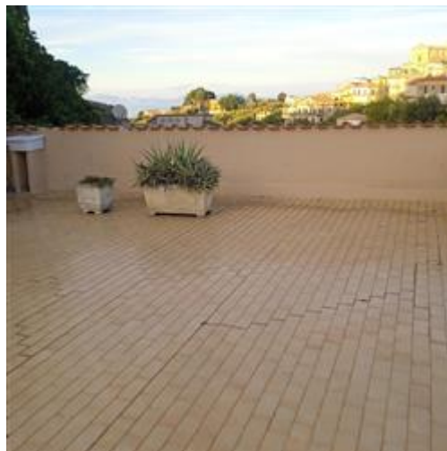
Foto n. 21 terrazza 3 piano terrazza appartamento Via delle Grazie 25 Particella 73
