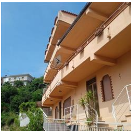
Foto n. 1 Lato esterno parete nord e ingresso dalla Via delle Grazie n.31 Appartamento foglio 17 particella sub 4
