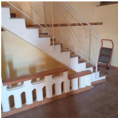
Foto n. 20 Scala di accesso al 3 piano terrazza appartamento Via delle Grazie 25 Particella 73
