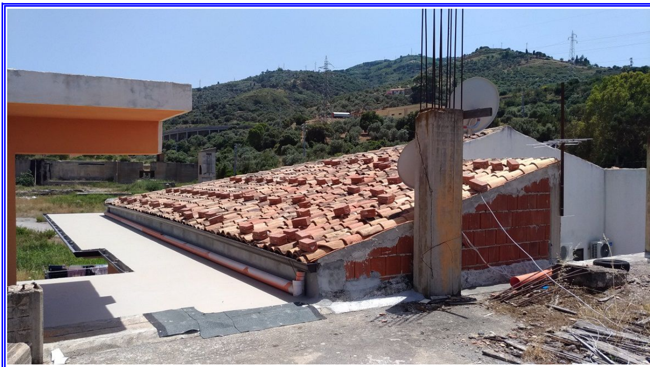
Foto 55: Vista, dal corpo di fabbrica attiguo, di parte della copertura. A sx il corpo scale
