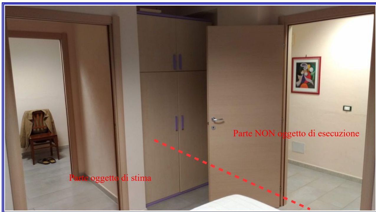
Foto 46: IP, Vista dall'ambiente spogliatoio “viola” verso i due distinti ingressi (da disimpegni)
