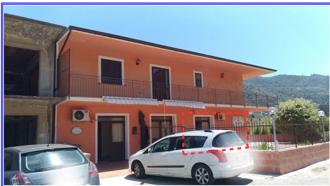
Foto 24: Vista, dell'ingresso principale al PT e di parte della corte esclusiva che lo fronteggia.
