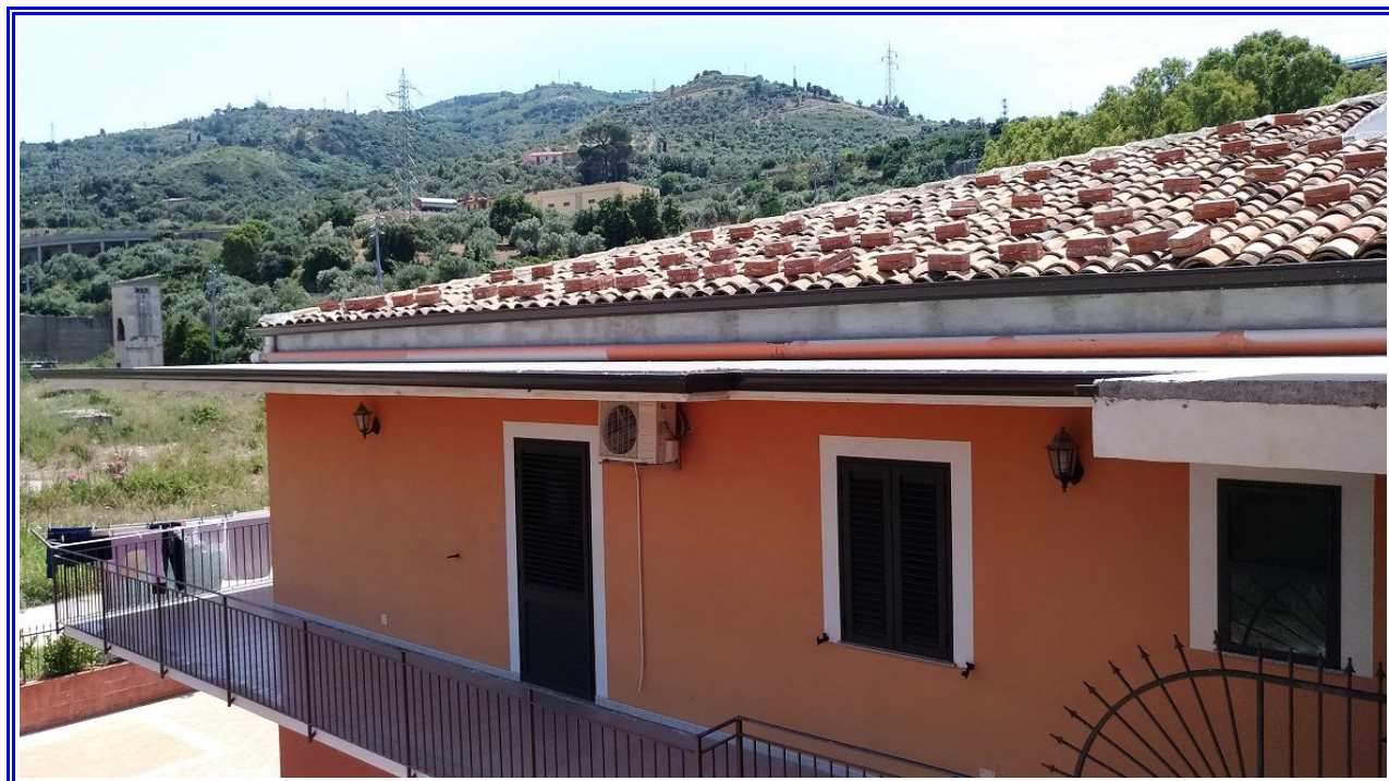
Foto 54: Vista, dal corpo scale, della copertura
