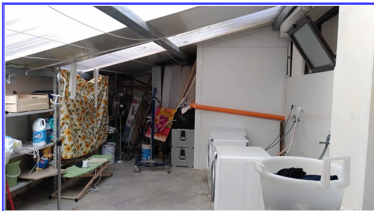
Foto 16: Vista, al PT, della chiostrina (allo stato coperta).
