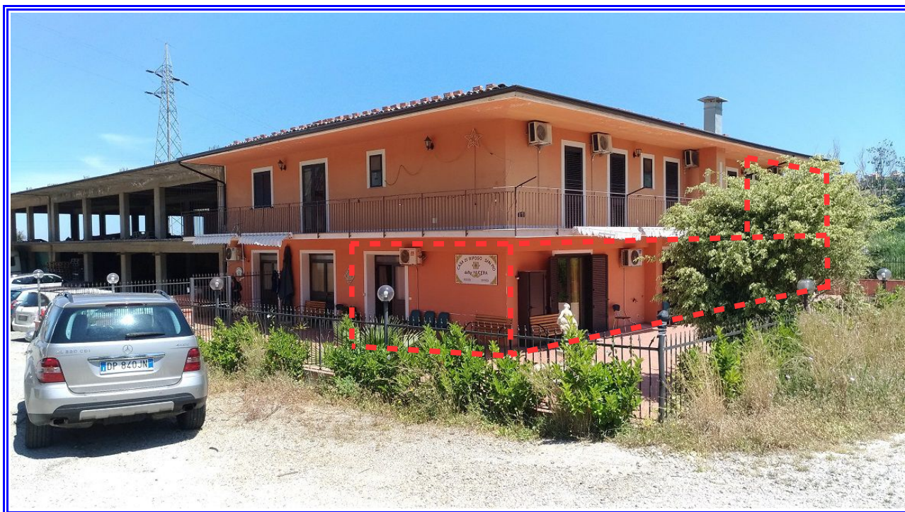
Foto 2: Vista, dalla strada privata carrabile di accesso, del fronte lato PA e del fianco lato monte, del complesso immobiliare parzialmente pignorato (in evidenza): parte del PT (ex subalterno 25) e parte del IP (ex subalterno 26)
