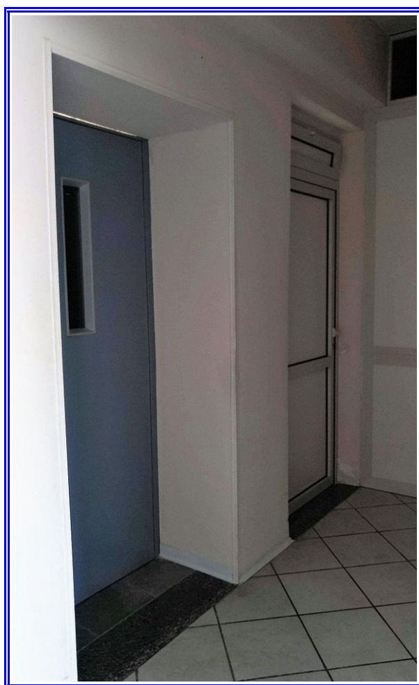
Foto 14: Vista, al PT, dell'ingresso alla piattaforma elevatrice ed, in fondo, alla chiostrina
