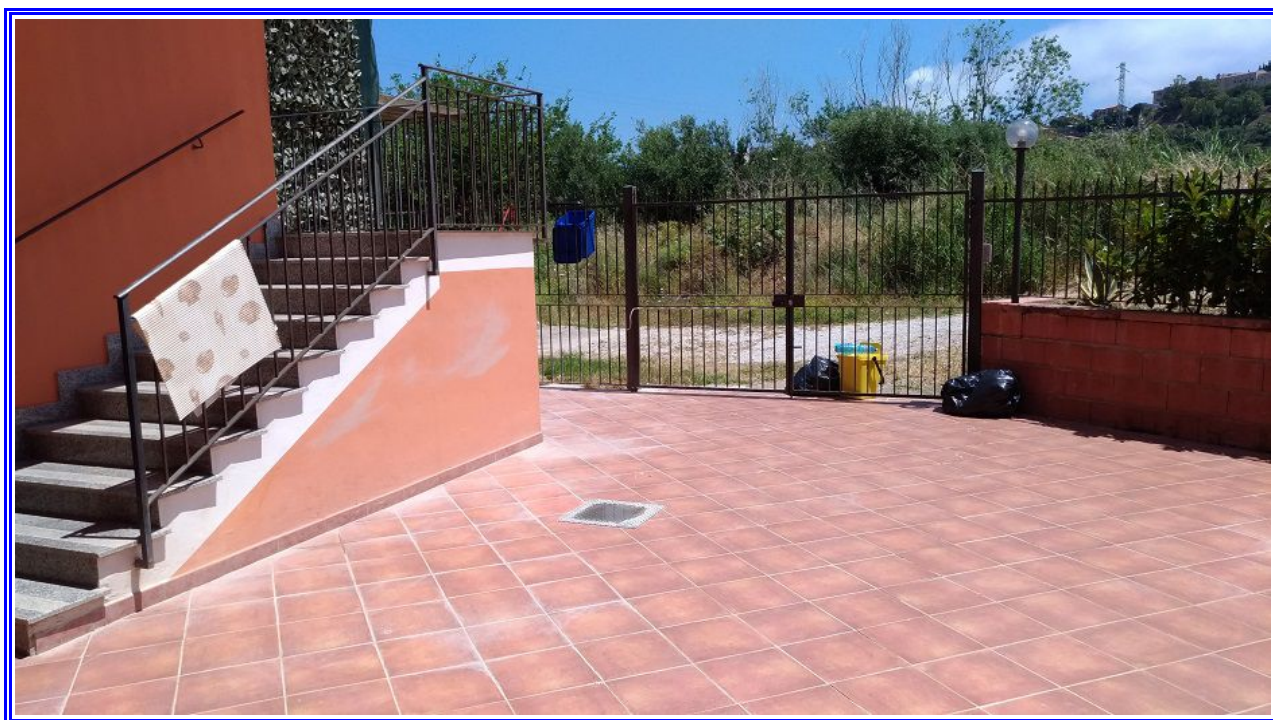
Foto 26: Vista di parte della corte esclusiva a terrazza sul retro del PT, a sx l'unica scala di accesso al IP
