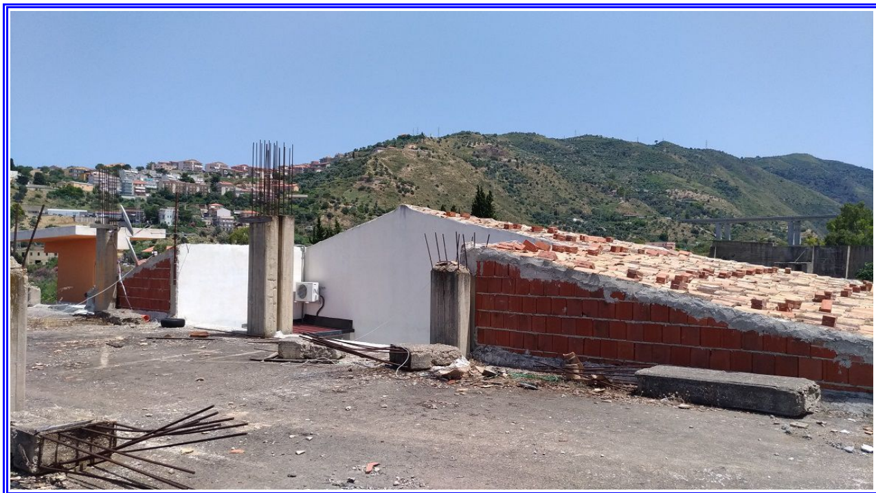
Foto 53: Vista, dal corpo di fabbrica attiguo, della copertura a falde inclinate
