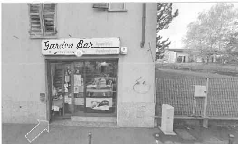
Fotografia n 4 - vista del fronte fabbricato con la vetrina di ingresso al negozio commerciale (bar)
