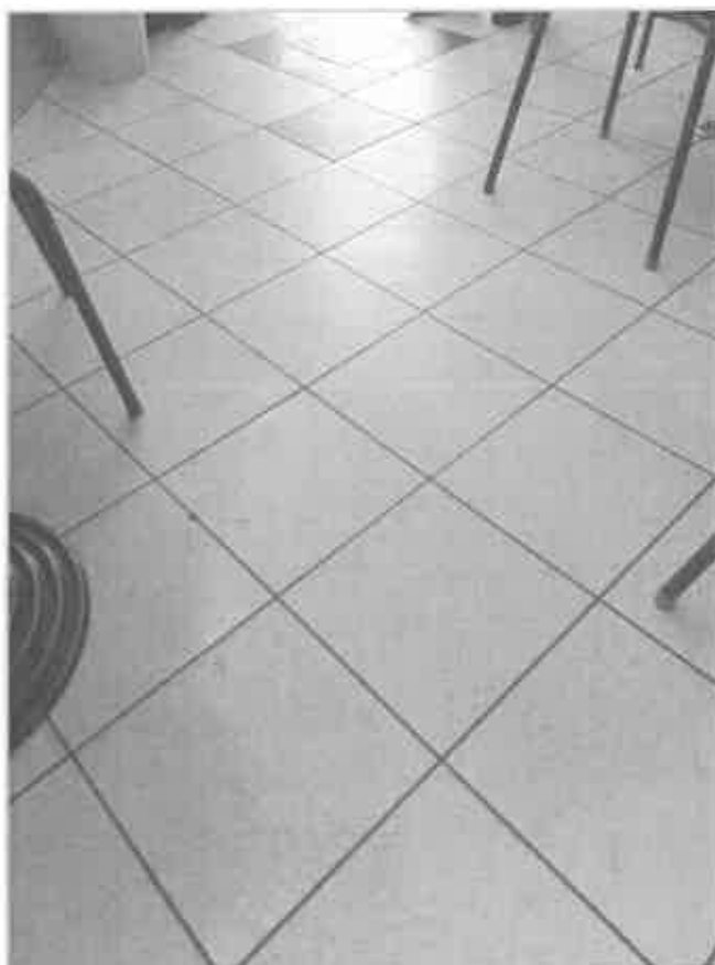
Fotografia n 13 - vista pavimento interno bar
