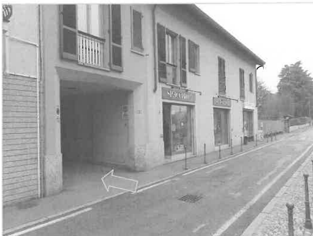
Fotografia n 3 - vista del fronte principale con il portone di accesso al cortile interno al fabbricato da via Volta
