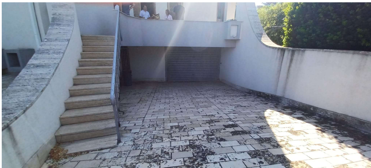
Foto n. 5 Vista esterna della rampa di accesso al piano interrato dalla traversa di via degli Eucalipti
