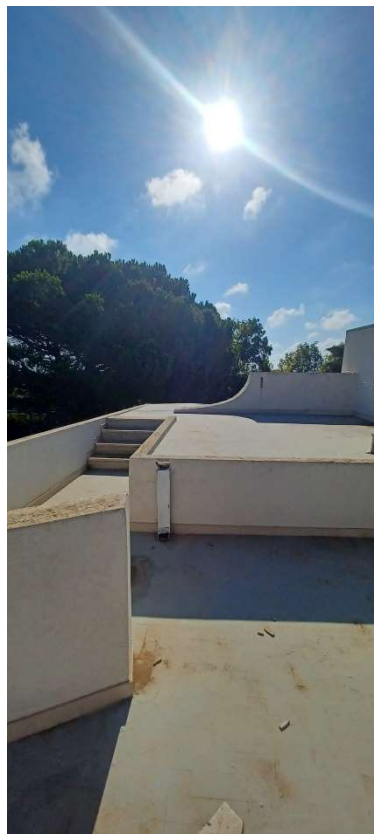
Foto n.40 Vista terrazzi solarium
