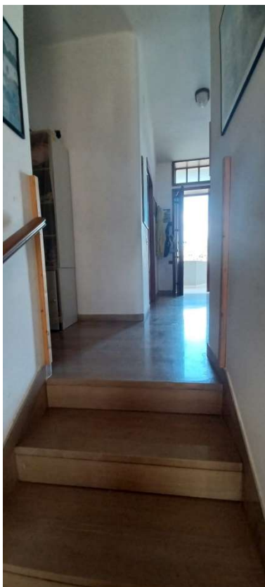
Foto n.19 Vista della scala di accesso p.Interrato
