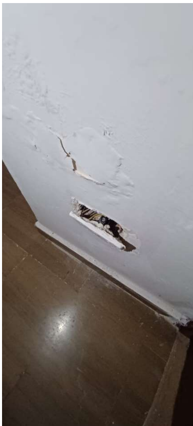
Foto n.41 Vista condizione muro p.interrato
