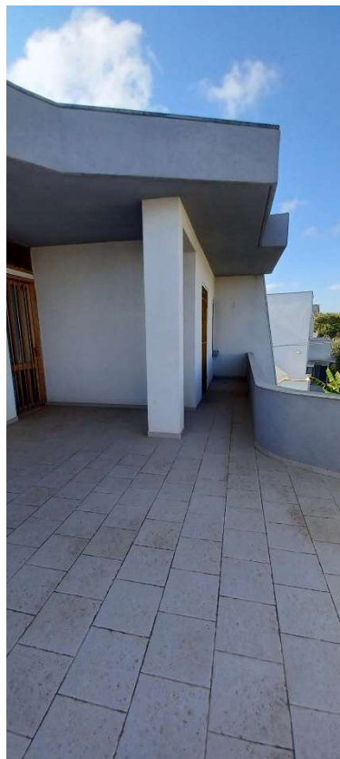
Foto n.30 Vista terrazzo livello zona notte
