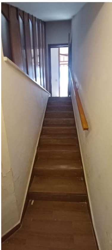
Foto n.31 Vista rampa di accesso al p.terra
