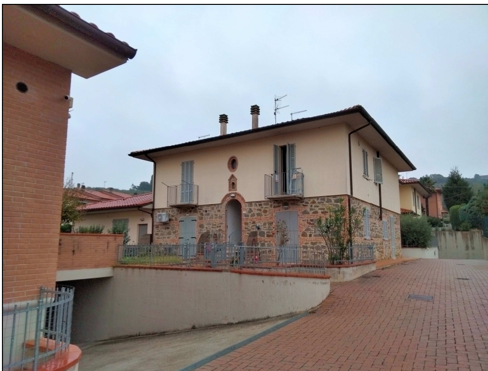
Foto n. 10 foto del fabbricato
