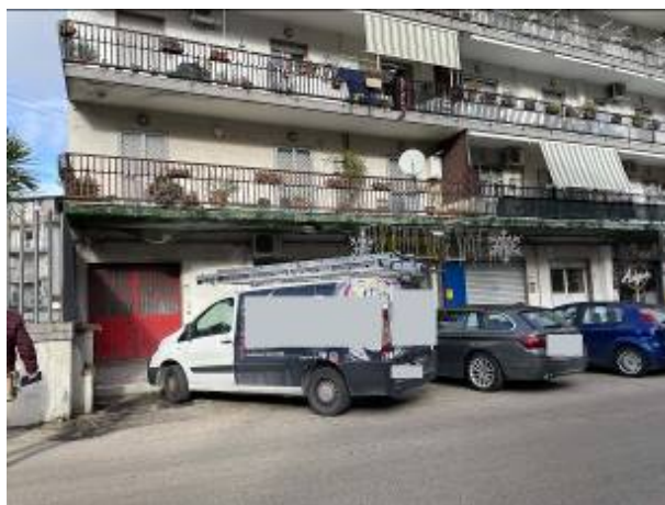
Fotografia n. 2 _ Particolare prospetto su via Fava
