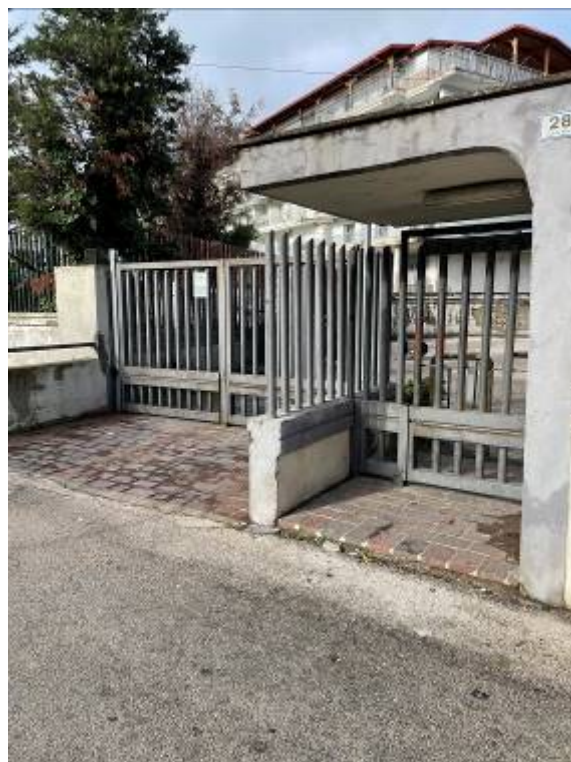
Fotografia n. 4 _ Ingresso all'area comune
