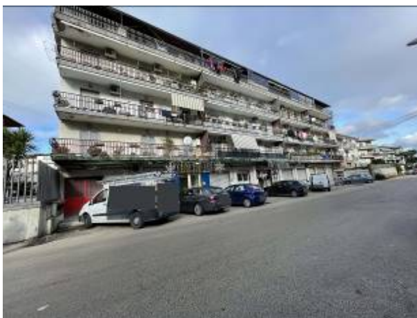
Fotografia n. 1 _ Prospetto su via Fava
