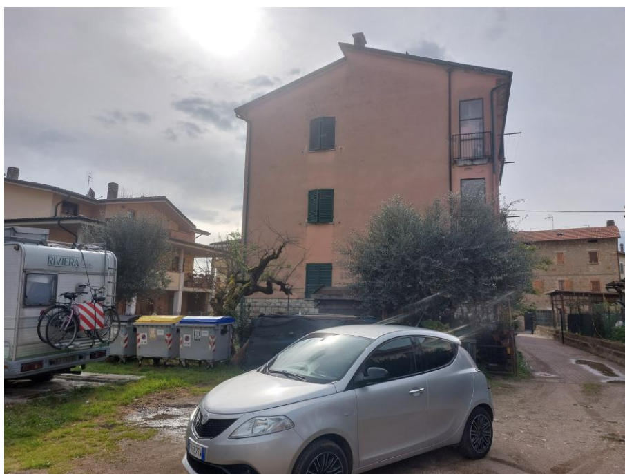
Foto n.6: Particolare del prospetto nord del fabbricato. Notare il tetto del tipo a due falde sfalsate con manto di copertura in tegola marsigliese.
