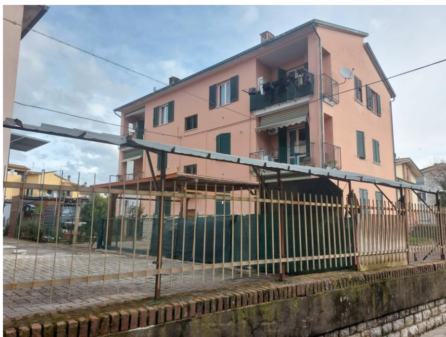
Foto n.2: Particolare dei prospetti ovest e sud del fabbricato (civico n.114). Notare le tamponature esterne intonacate e tinteggiate, i balconi con parapetti protetti da ringhiera metallica, i canali di gronda e i pluviali discendenti in lamiera zincata verniciata.
