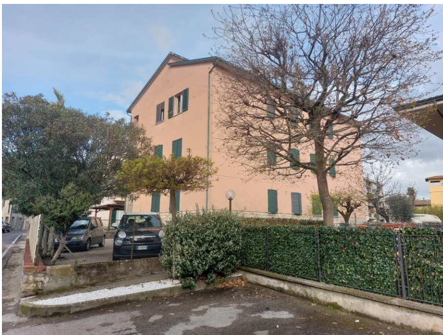
Foto n.3: Particolare dei prospetti est e sud del fabbricato del fabbricato (civico n.114). Notare il tetto del tipo a due falde sfalsate e le persiane protettive esterne in legno. È visibile, sulla sinistra dell'immagine, la recinzione perimetrale esterna costituita da muretto in calcestruzzo con sovrastante rete metallica.
