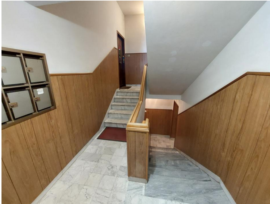
Foto n.11: Altro particolare del vano scala comune al piano terra ripreso da angolazione opposta rispetto all'immagine precedente. Notare le pareti intonacate e tinteggiate e parzialmente rivestite con perline in legno.
