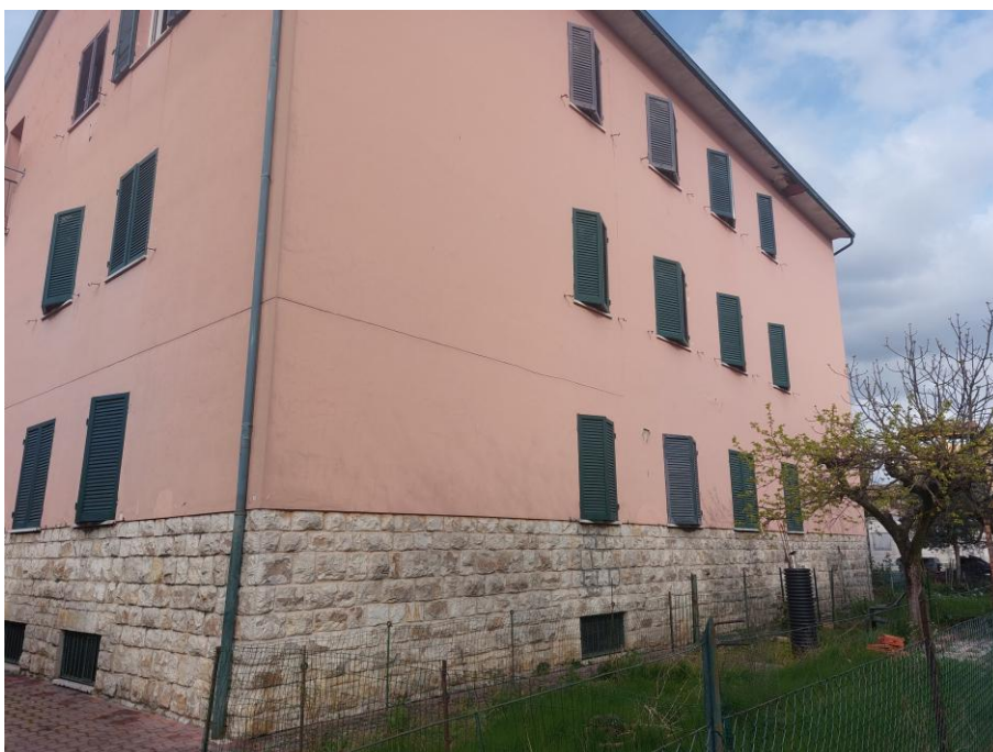
Foto n.4: Particolare dei prospetti est e sud del fabbricato. Notare le tamponature esterne di diversa tipologia, parte intonacate e tinteggiate e parte in pietra facciavista. Sono visibili, in basso, le finestre del piano sottostrada protette da inferiate in metallo e la zona sistemata a verde della corte comune.
