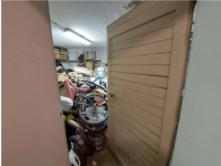
Foto n.13: Particolare interno del locale adibito a fondo al piano sottostrada. Notare, il pavimento in battuto di cemento, la porta in legno di accesso al locale e l'impianto elettrico fuori traccia.
