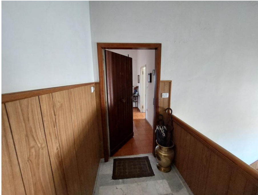
Foto n.15: Particolare dell'ingresso all'appartamento al secondo piano. Sono visibili, in primo piano, il portoncino in legno blindato e sullo sfondo il disimpegno di smistamento. Notare le pareti intonacate e tinteggiate e parzialmente rivestite con perline in legno del pianerottolo.
