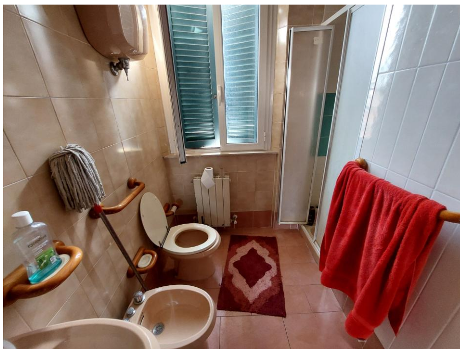
Foto n.21: Particolare del bagno al secondo piano. Notare l'elemento radiante dell'impianto di riscaldamento in alluminio, il box doccia e i sanitari. É visibile, sullo sfondo, la finestra con affaccio sul prospetto est dotata di infisso PVC e persiana in legno
