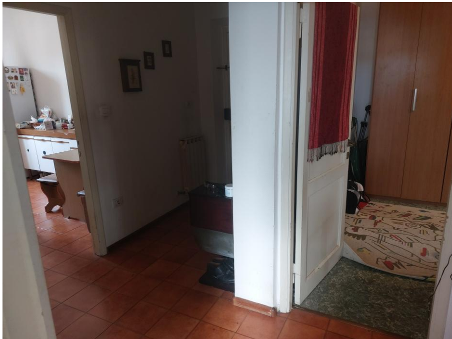
Foto n.16: Particolare del disimpegno di smistamento dell'appartamento al secondo piano. Sono visibili, centralmente l'ingresso dell'appartamento delimitato da portoncino in legno, sulla sinistra, l'apertura che immette alla cucina e sulla destra, l'apertura che immette alla camera più piccola. Notare, il pavimento in monocottura e le pareti intonacate e tinteggiate.
