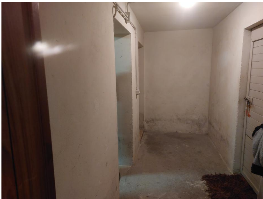
Foto n.12: Particolare del vano comune al piano sottostrada. È visibile, al centro dell'immagine l'accesso al fondo. Notare le pareti intonacate e tinteggiate, il pavimento in battuto di cemento e l'impianto elettrico fuori traccia.
