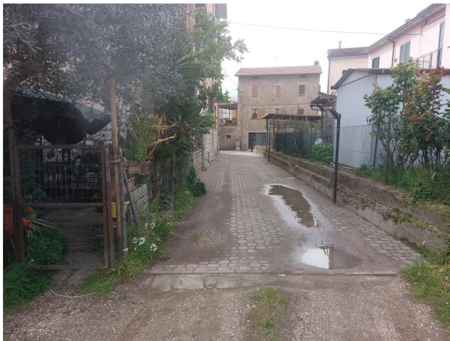
Foto n.7: Particolare della corte comune sul prospetto ovest. É visibile, centralmente la zona della corte lastricata adibita a viabilità e, sulla destra dell'immagine, la recinzione perimetrale esterna costituita da muretto con sovrastante rete metallica sul prospetto ovest.
