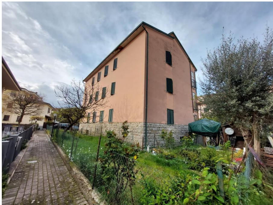
Foto n.5: Particolare dei prospetti est e nord del fabbricato. Notare le tamponature esterne di diversa tipologia. Sono visibili nell'immagine, la zona sistemata a verde della corte comune e la recinzione perimetrale esterna costituita da muretto con sovrastante rete metallica sul prospetto est.
