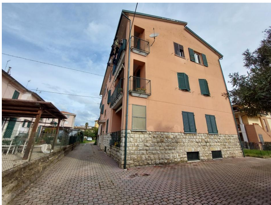
Foto n.8: Particolare del prospetto sud del fabbricato ripreso da angolazione opposta rispetto all'immagine precedente. Notare le persiane esterne in legno, le finestre del piano sottostrada protette da inferiate in metallo e la zona della corte comune lastricata adibita a viabilità e parcheggio. È visibile, sullo sfondo, la pensilina dove ubicato l'ingresso principale al fabbricato.
