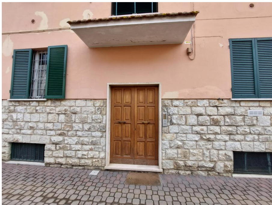
Foto n.9: Particolare dell'ingresso principale al fabbricato al piano terra sul prospetto ovest (civico n.114). È visibile in foto il portone in legno a due ante con sovrastante pensilina. Notare le tamponature esterne di diversa tipologia, parte in pietra facciavista e parte intonacate e tinteggiate.
