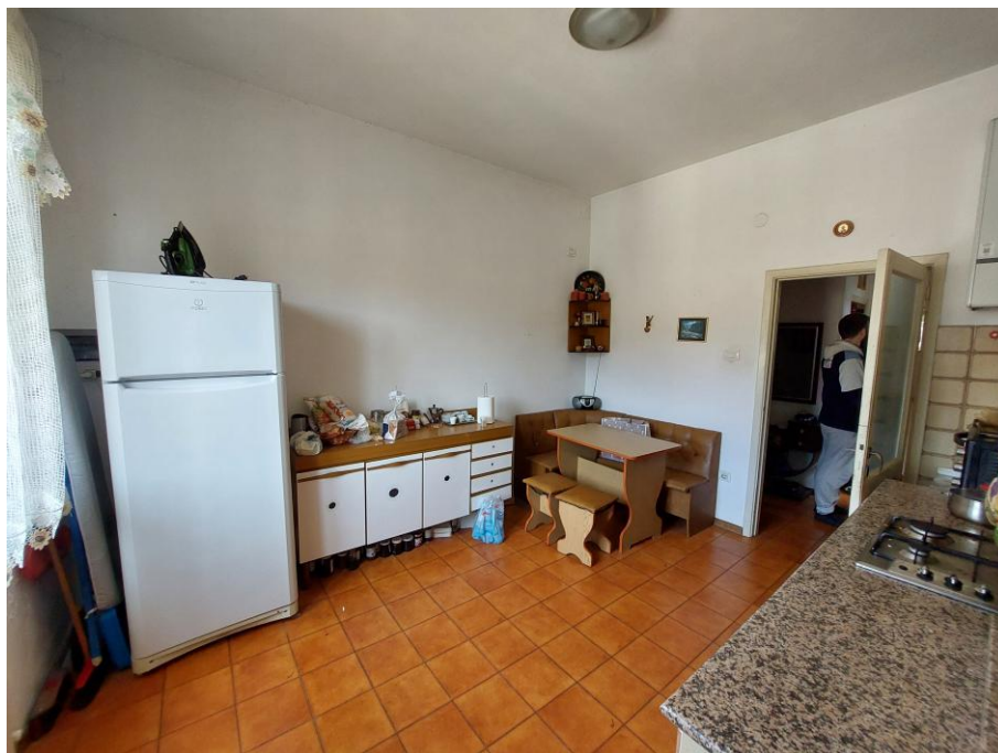
Foto n.19: Particolare della cucina al secondo piano. È visibile al centro la porta in legno vetrata che delimita l'ingresso alla cucina. Notare, il pavimento in monocottura e le pareti intonacate e tinteggiate.
