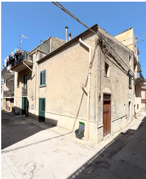
Foto 1- Prospetto Sud ed Est
