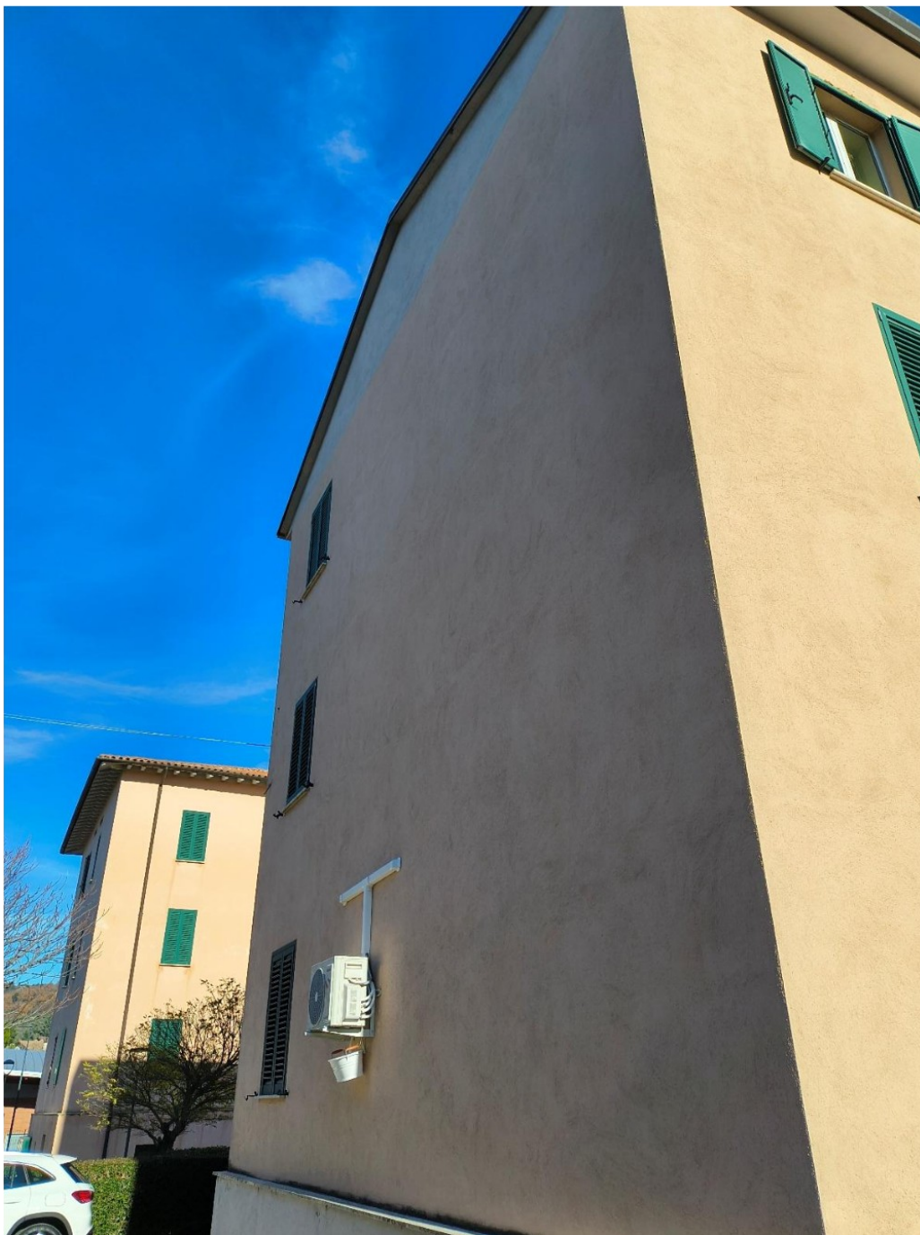
PROSPETTO OVEST FABBRICATO CONDOMINALE
