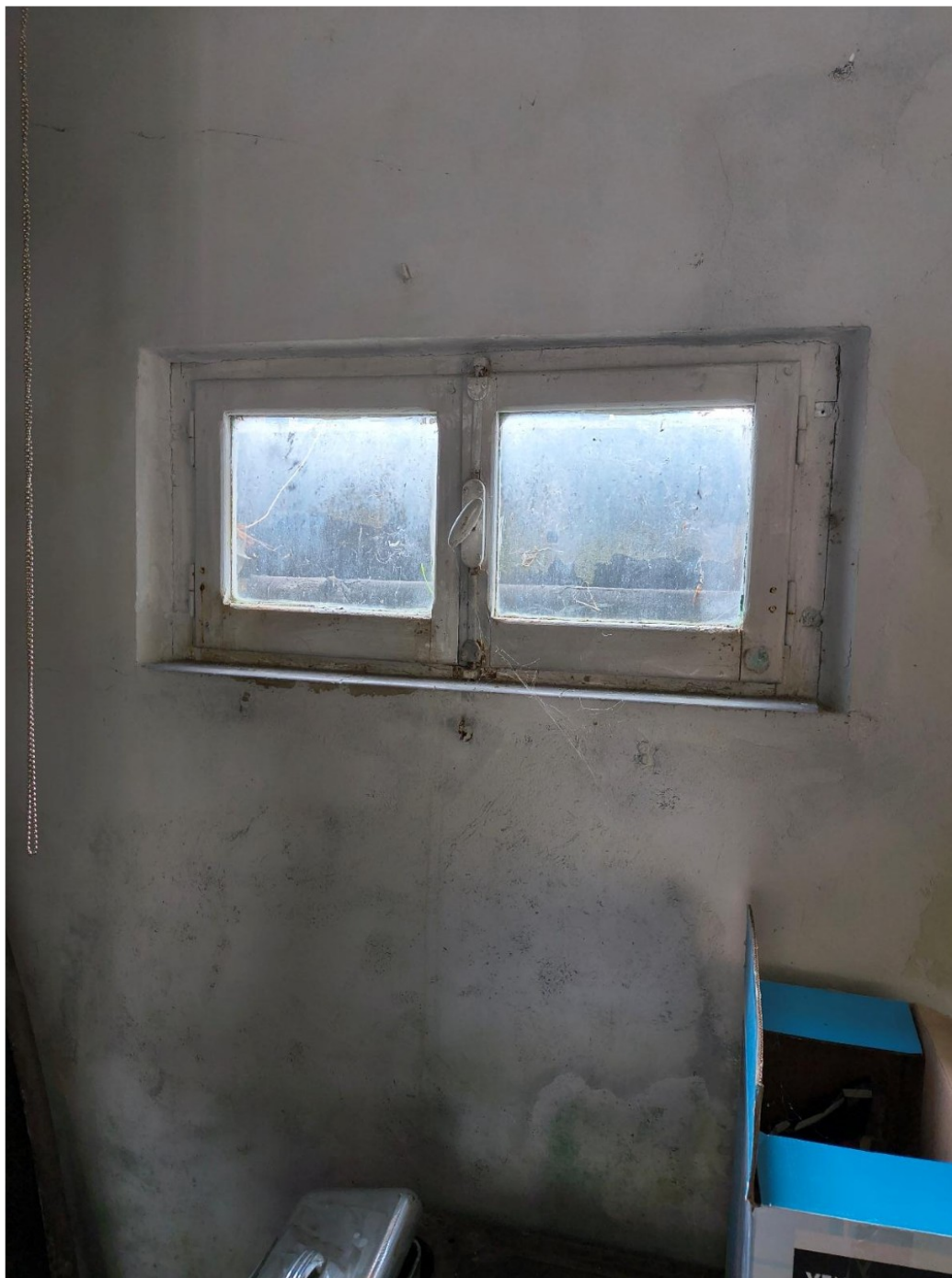
FINESTRA DEL GARAGE CHE AFFACCIA SUL PROSPETTO SUD
