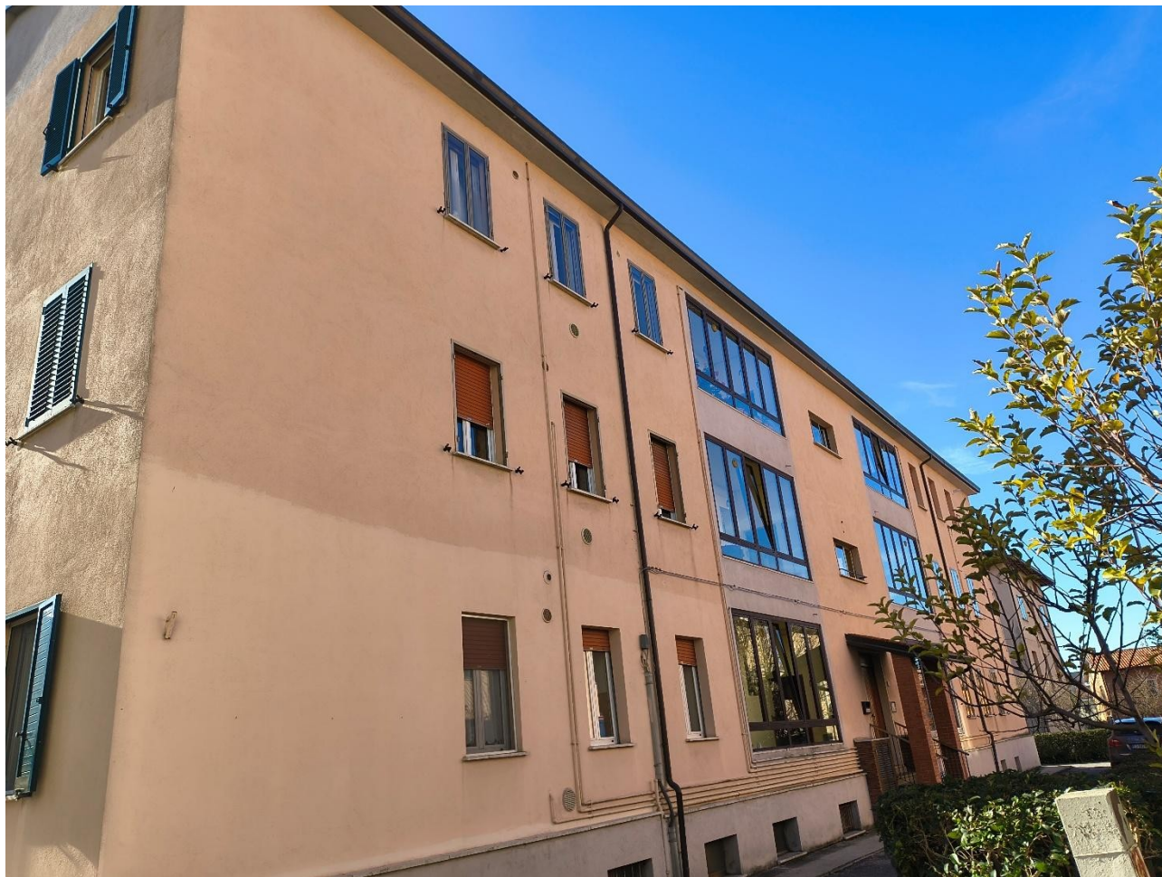
PROSPETTO NORD FABBRICATO CONDOMINALE
