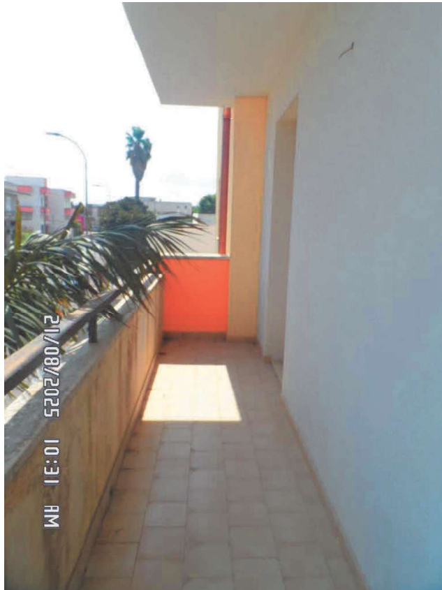
Vista esterna: BALCONE
