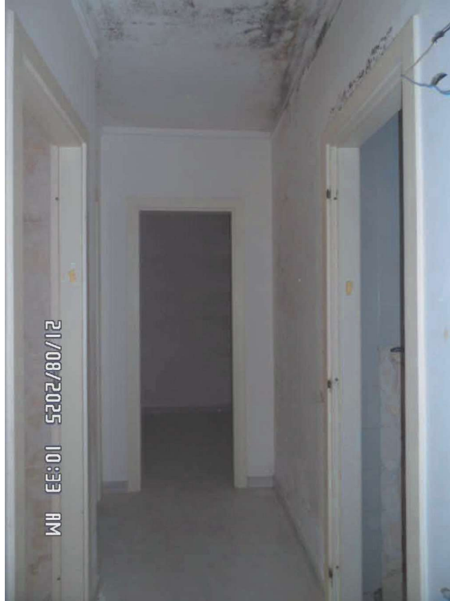
Vista interna: DISIMPEGNO
