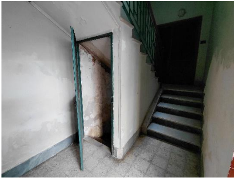
ingresso verso deposito interrato
