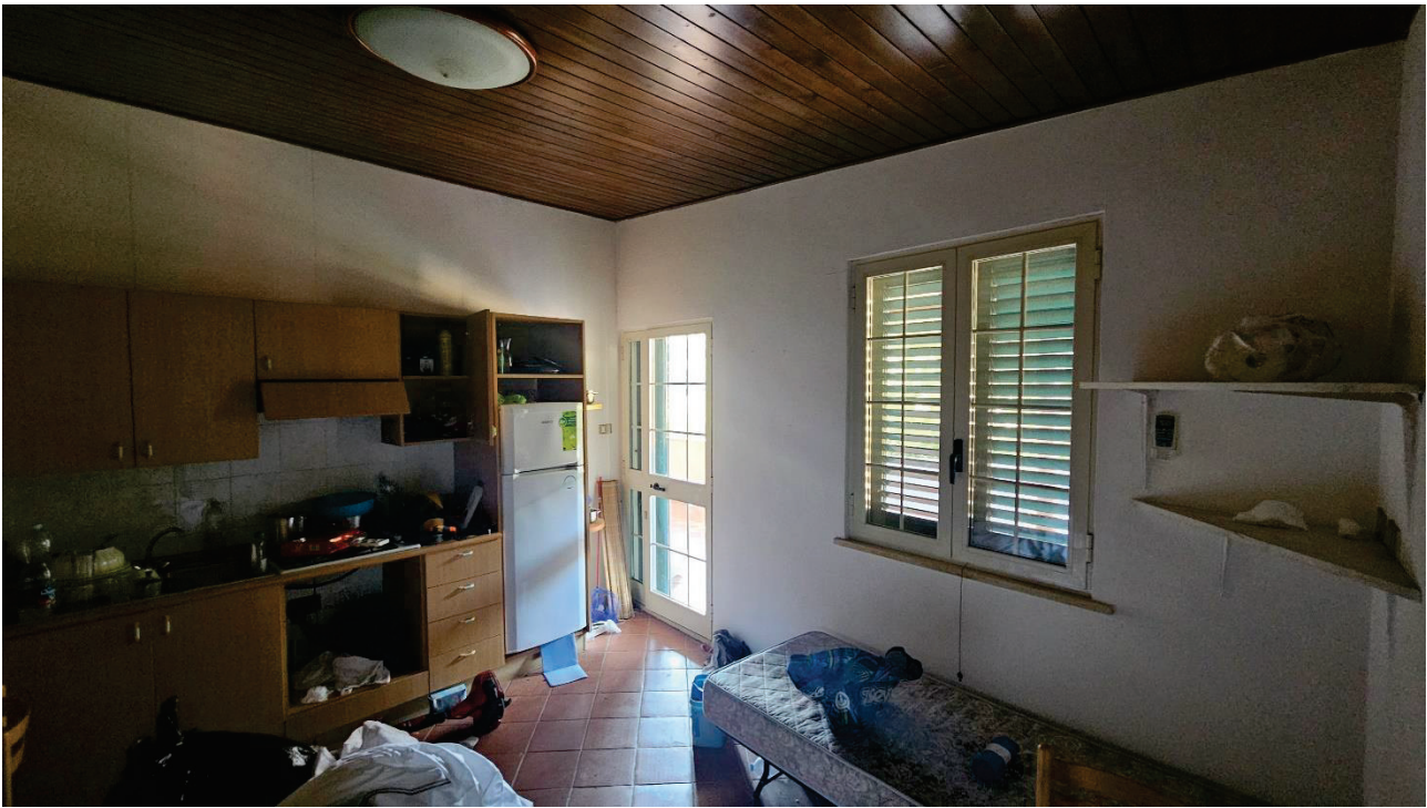
Camera aggiuntiva ricavata sotto la tettoia
