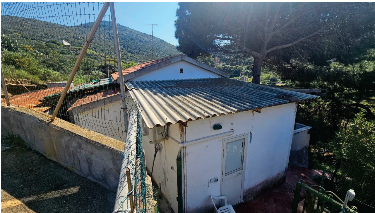
Esterno fabbricato con vista tettoia tamponata
