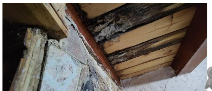
DEGRADO STRUTTURA LIGNEA COPERTURA CUCINA RUSTICA (In presenza di fenomeni di umidità compatibili con infiltrazioni)
