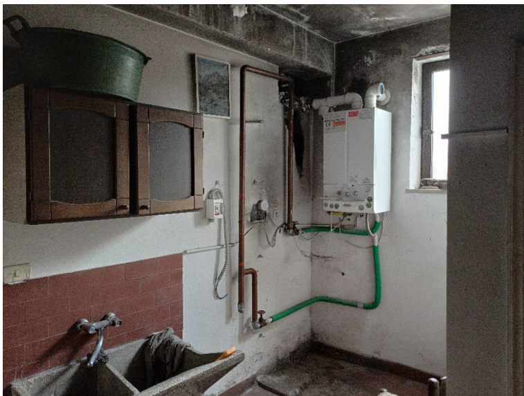
P.S1. – LOCALE TECNICO
