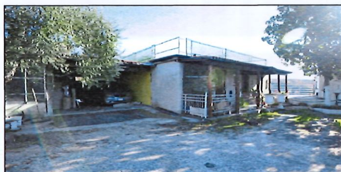
31 foto lotto 4 edificio sub 2 con tettoie e varie
