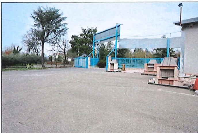
26 foto vista ingresso lotto 4 dall'interno
