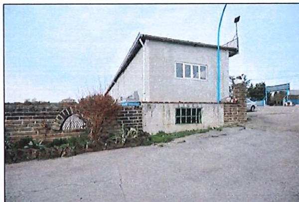
34 foto lotto 4 edificio sub 4 porzione ampliata
