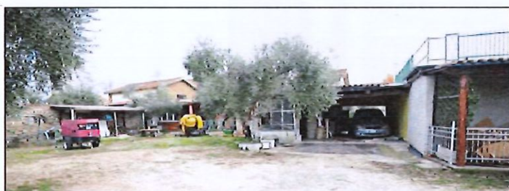
29 foto interno lotto 4 con tettoie e varie
