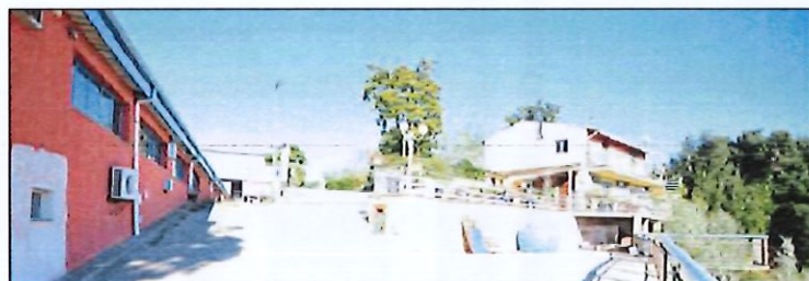
30 foto lotto 4 edificio sub 3 con tettoie e varie
