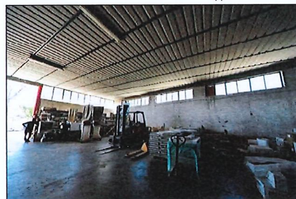
39 foto lotto 4 edificio sub 4 magazzino
