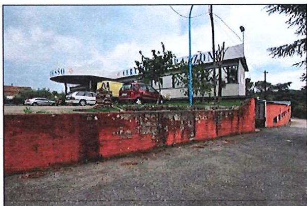
33 foto lotto 4 edificio sub 4 vista d'insieme da rampa
