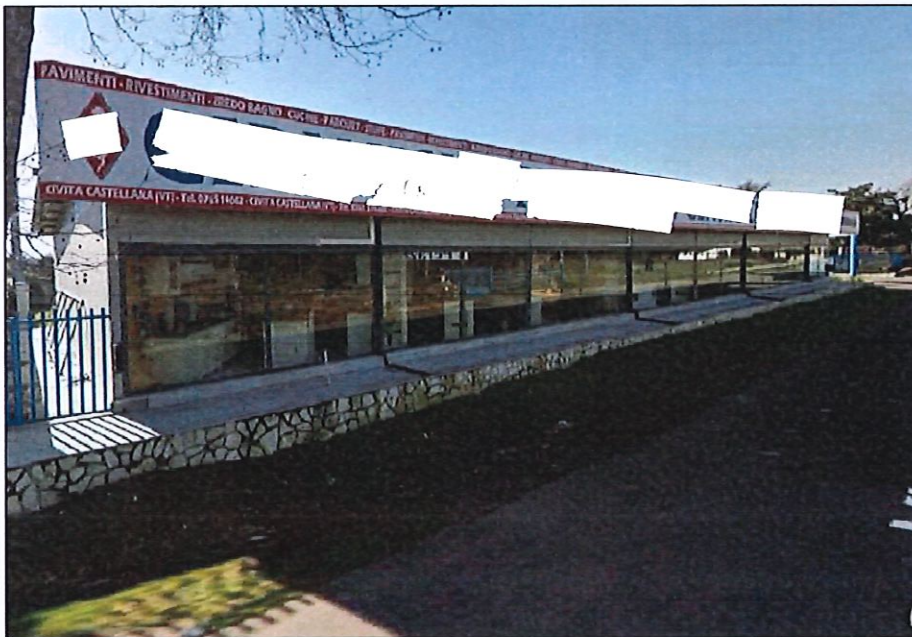
24 foto vista sala mostra cucine lotto 4
