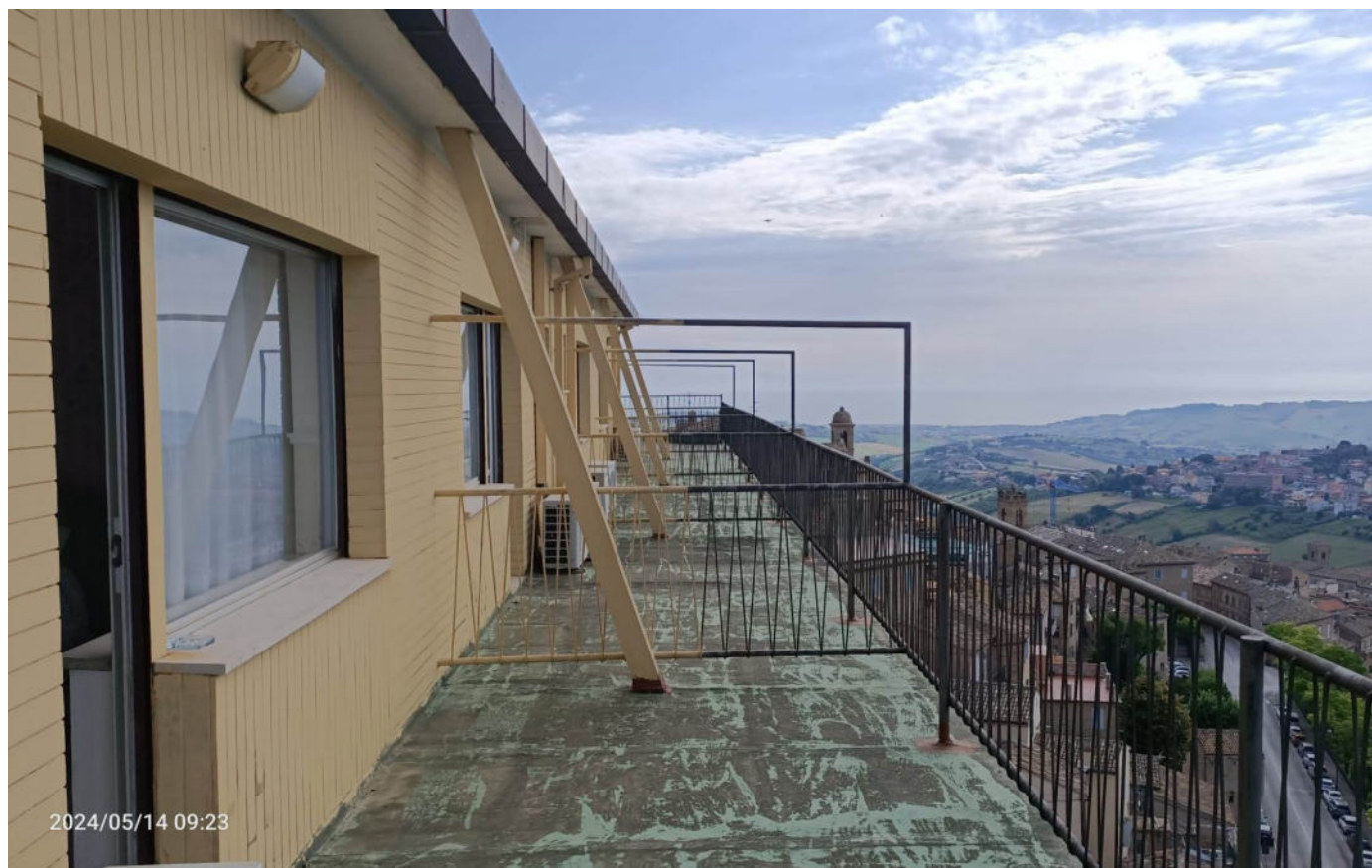
Comune di Fermo, Foglio 62 Particella 617 piano 2° terrazze delle camere
