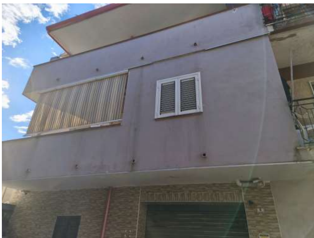
VISTE ESTERNE DELLA PORZIONE DI FABBRICATO DA VIA M. B. GRECO E VIA PACIFICO
