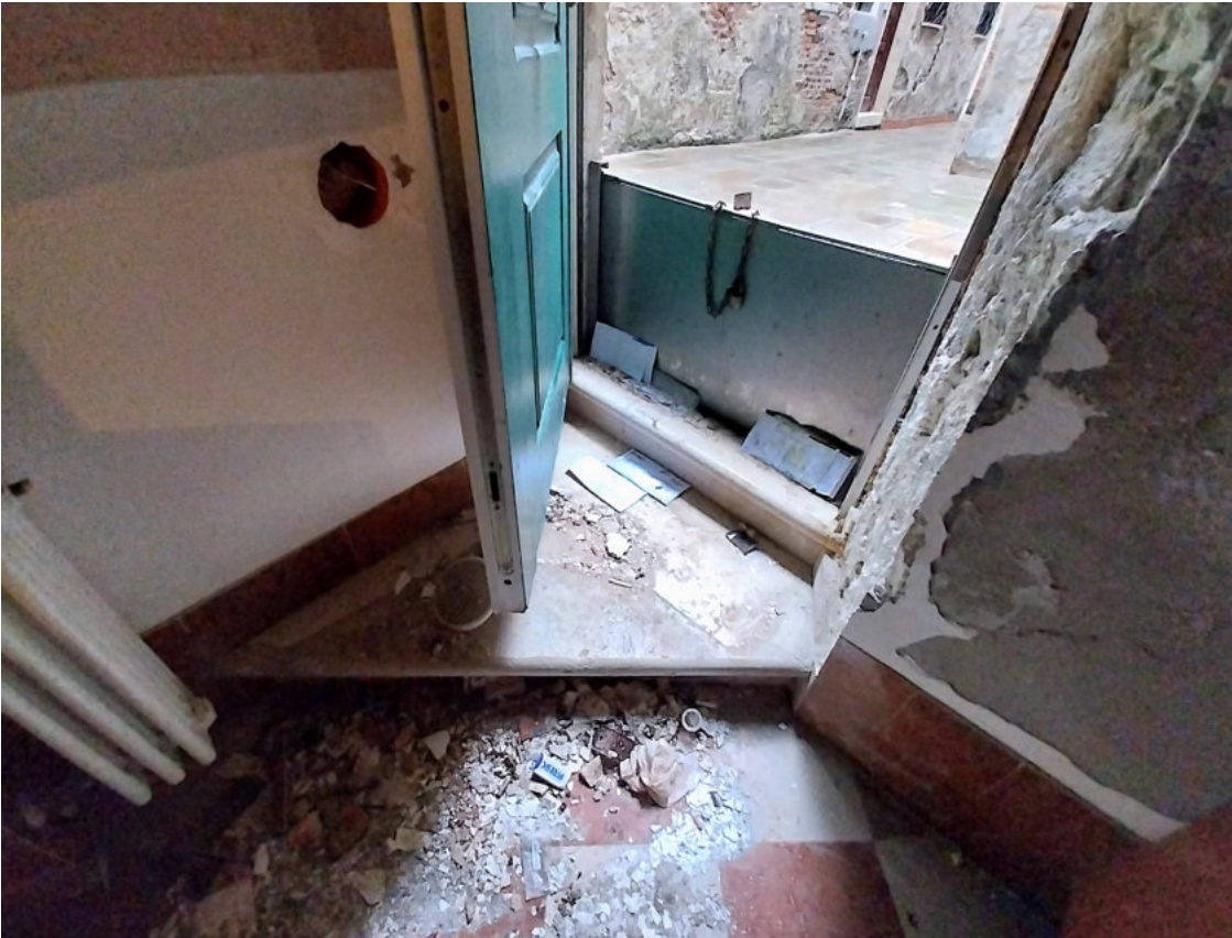
Foto n. 5 - Vano 1 – particolari scalini ingresso
