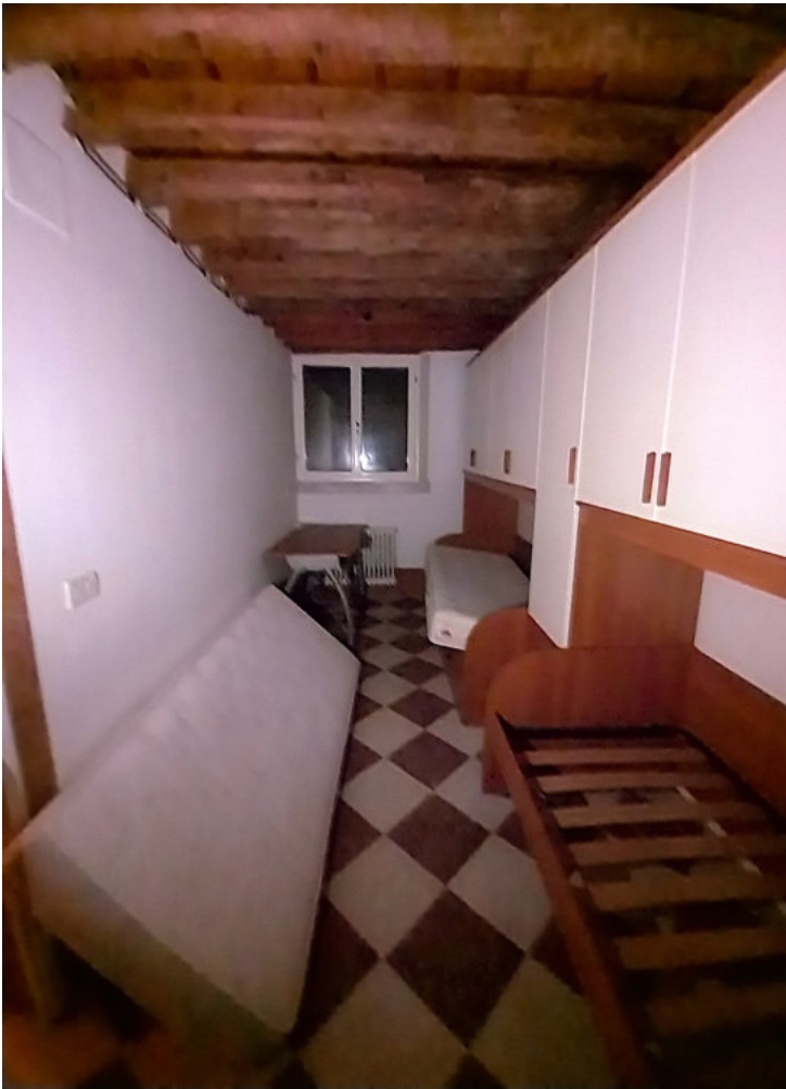
Foto n. 13 – Magazzino ad uso camera (lato Rio dei Scudi)
