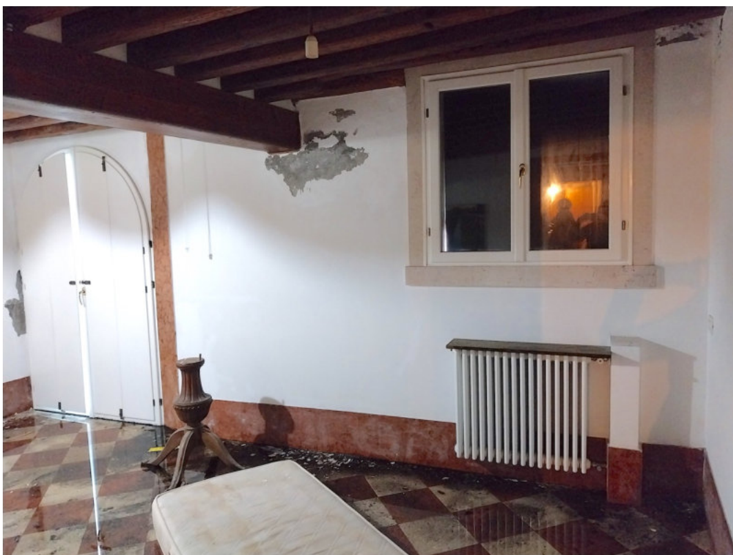
Foto n. 12 – Vano con porta d'acqua su Rio dei Scudi
