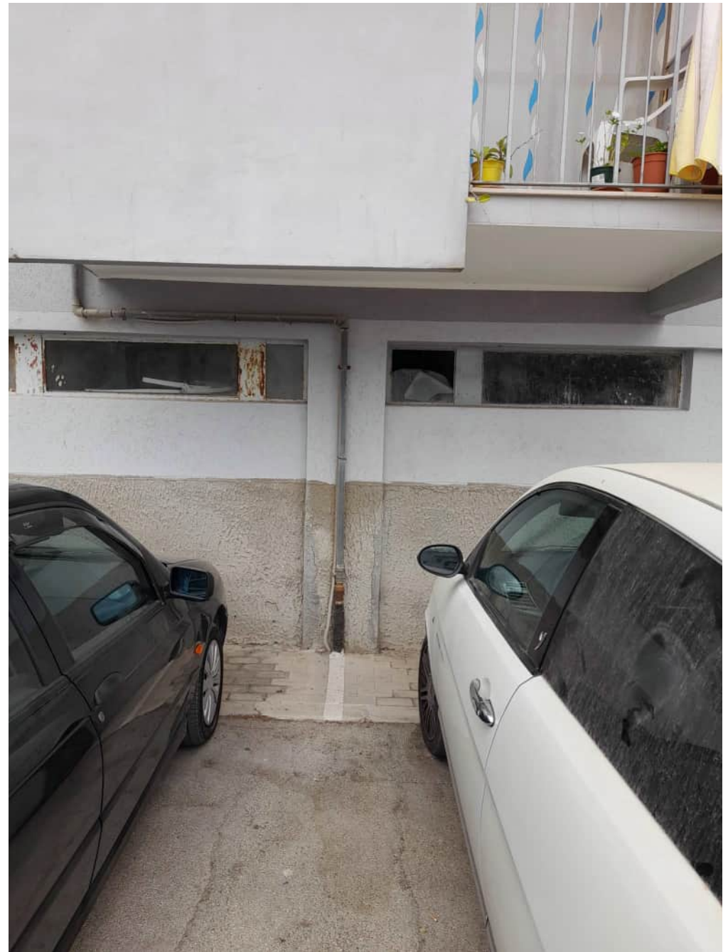
Foto n°20 - Vista esterna della cantina di pertinenza
