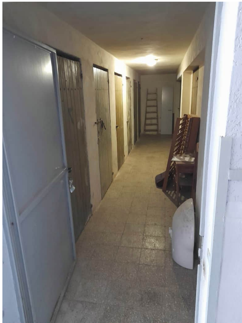
Foto n°18 - Vista interna del corridoio comune delle cantine
