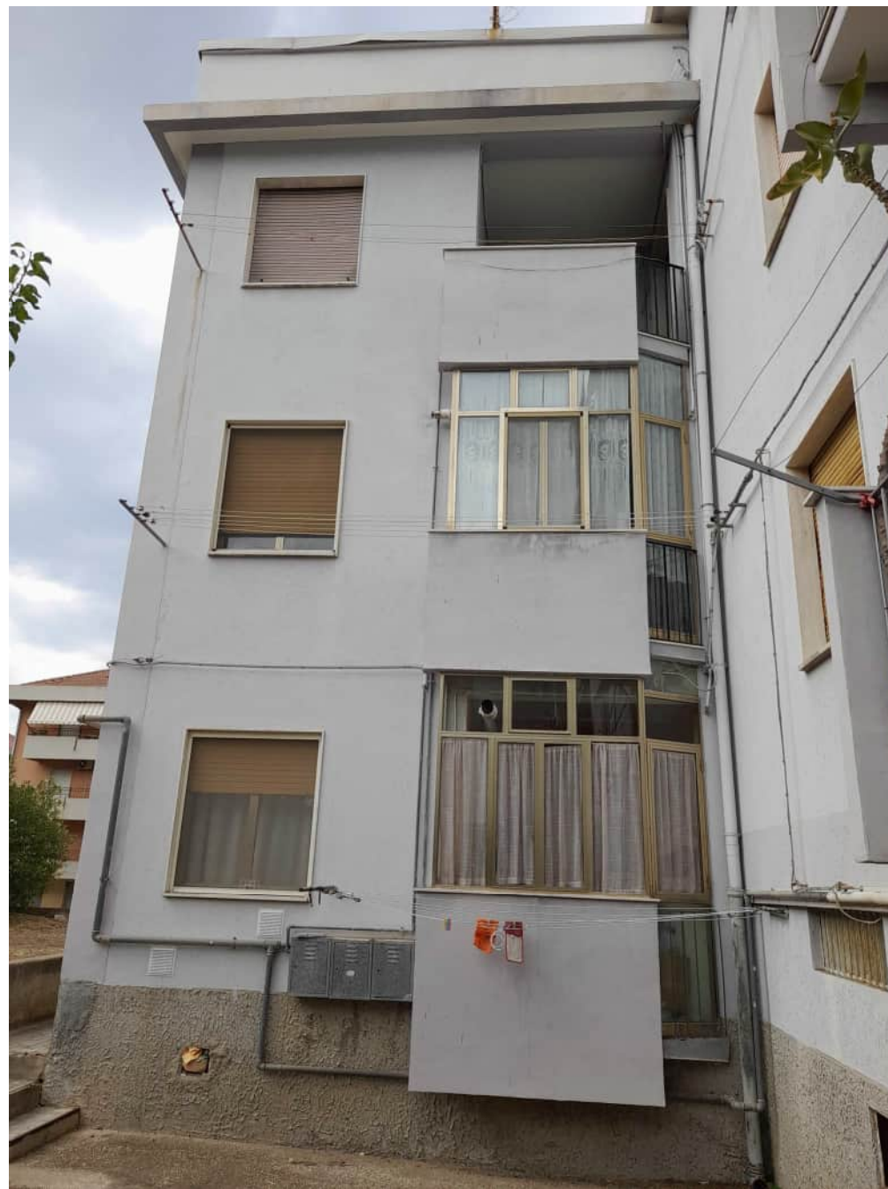
Foto n°4 - Vista del prospetto Sud
