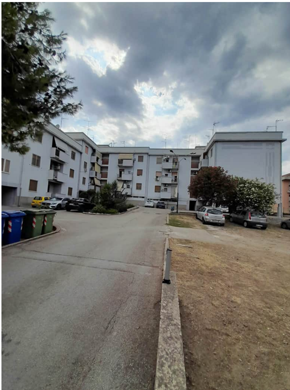
Foto n°1 - Vista del complesso edilizio denominato Condominio Jonio
