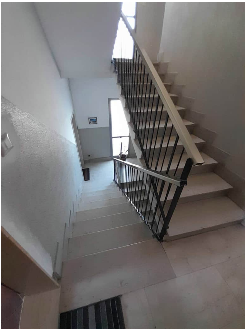
Foto n°5 - Vista del vano scala
