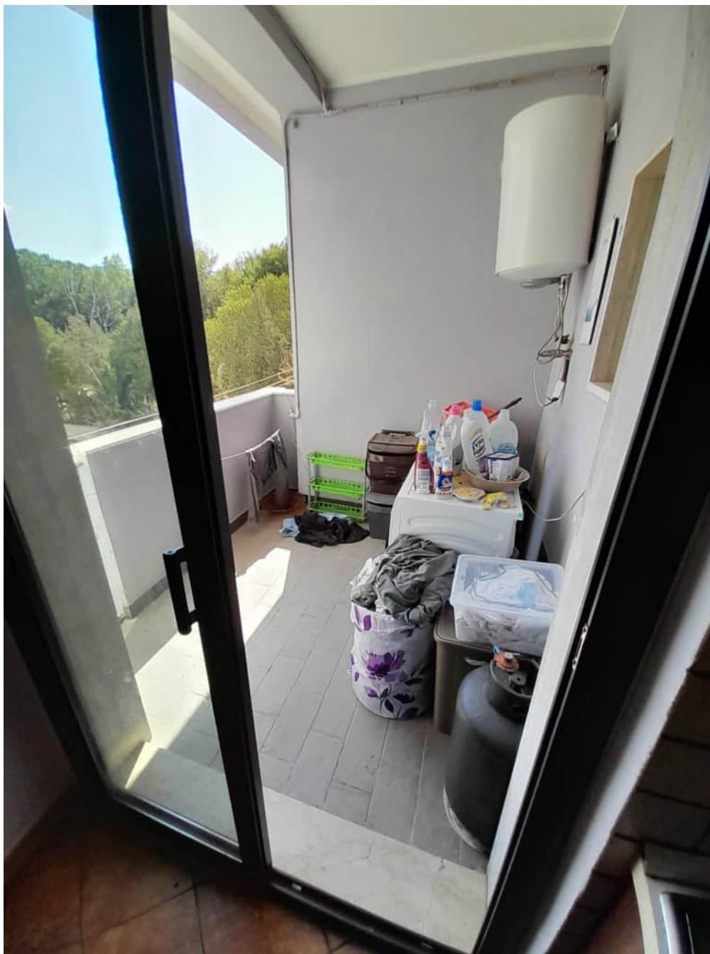
Foto n°17 - Vista della veranda coperta sul prospetto Sud
