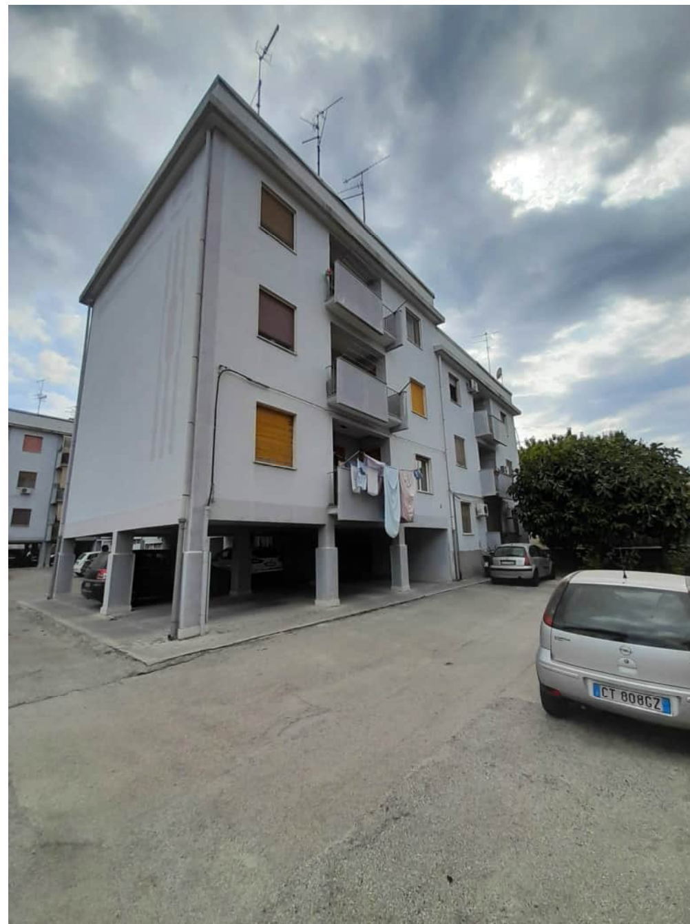
Foto n°2 - Vista della scala C del complesso edilizio
