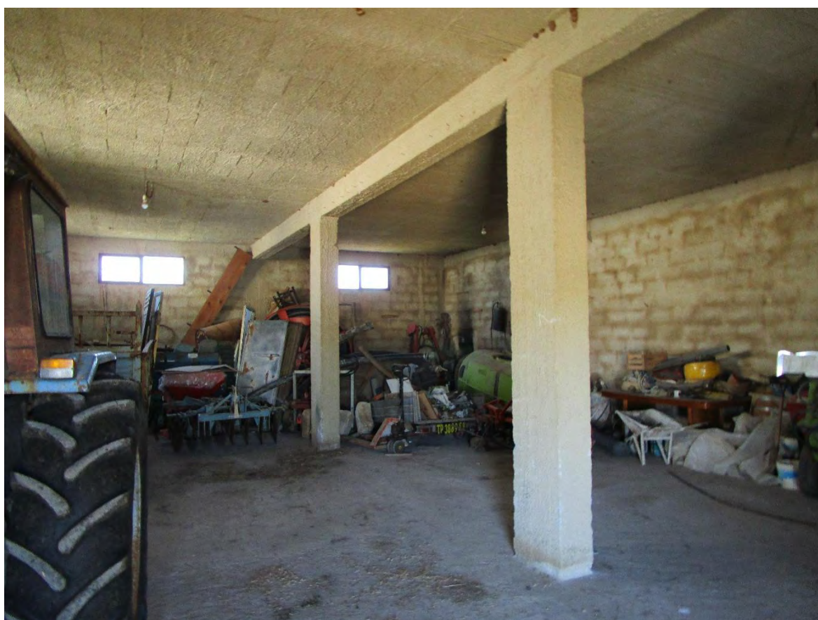
Immobile sito in Marsala c\da Colombaio Lasagna – Vista interna magazzino deposito.
