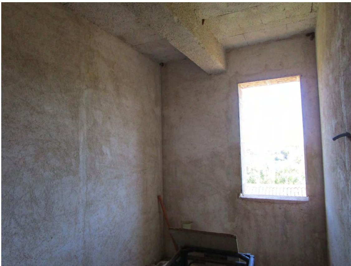
Immobile sito in Marsala c\da Colombaio Lasagna – Vista interna del bagno sul lato nord in corso di costruzione
