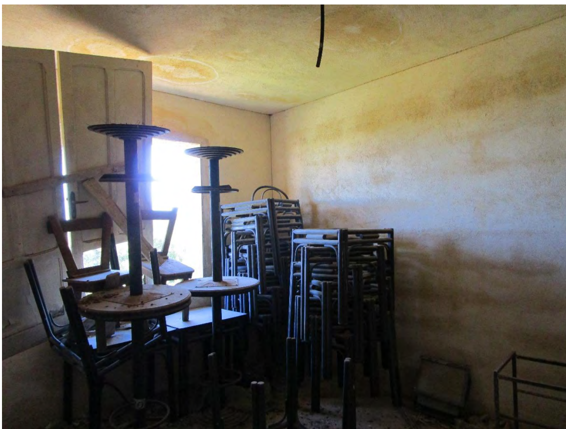
Immobile sito in Marsala c\da Colombaio Lasagna – Vista interna del vano letto sul lato nord in corso di costruzione.
