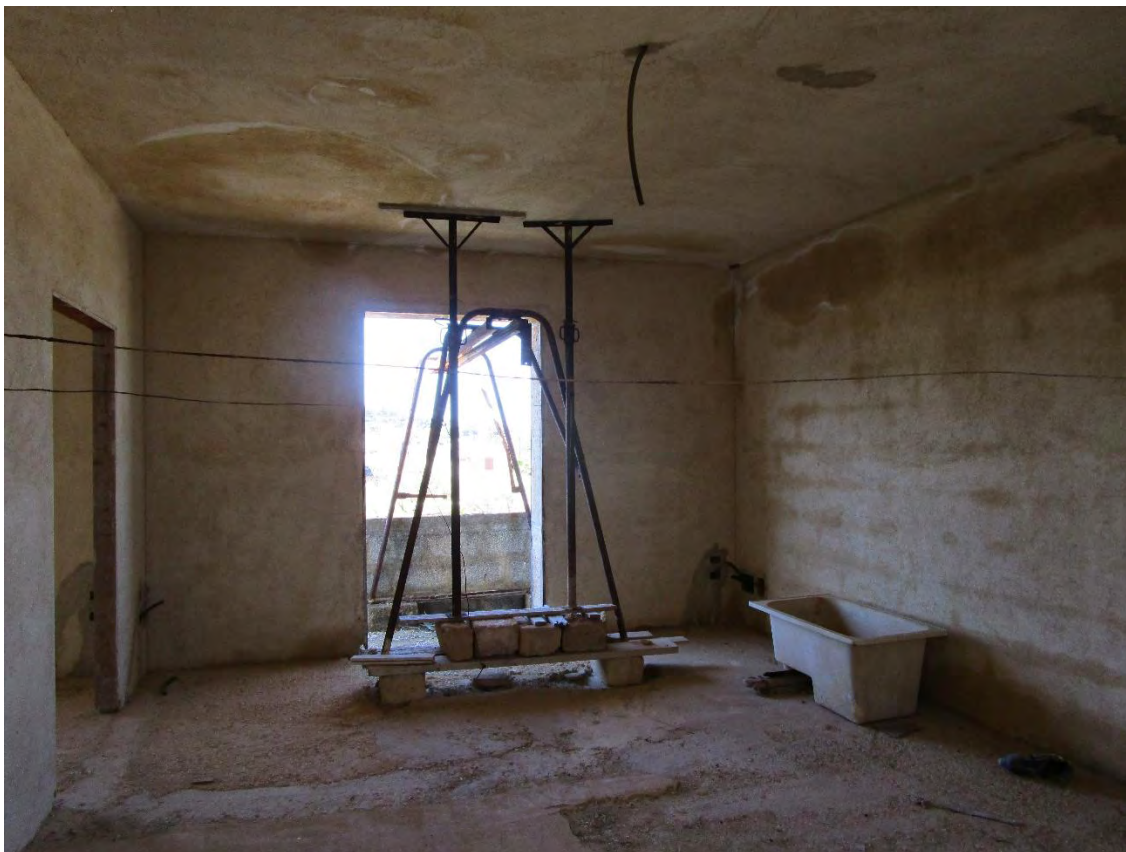
Immobile sito in Marsala c\da Colombaio Lasagna – Vista interna del soggiorno ingresso in corso di costruzione.
