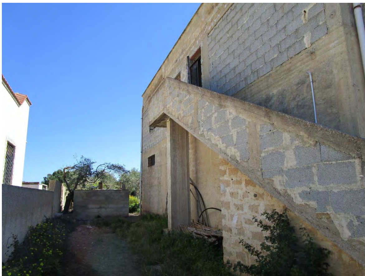
Immobile sito in Marsala c\da Colombaio Lasagna – Vista prospetto laterale nord-ovest, scala esterna di accesso al piano primo e vasca in c.a. per raccolta acqua.
