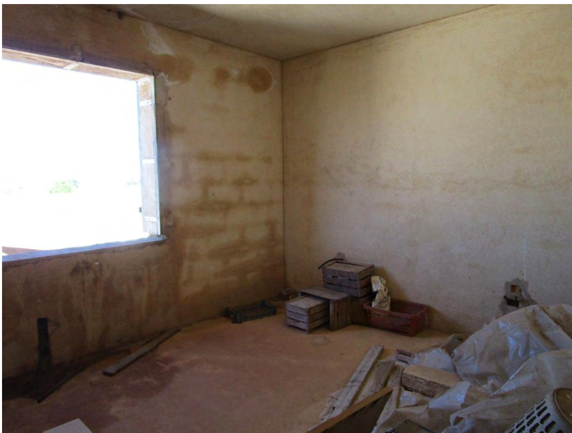
Immobile sito in Marsala c\da Colombaio Lasagna – Vista interna del vano letto sul lato nord-ovest in corso di costruzione.
