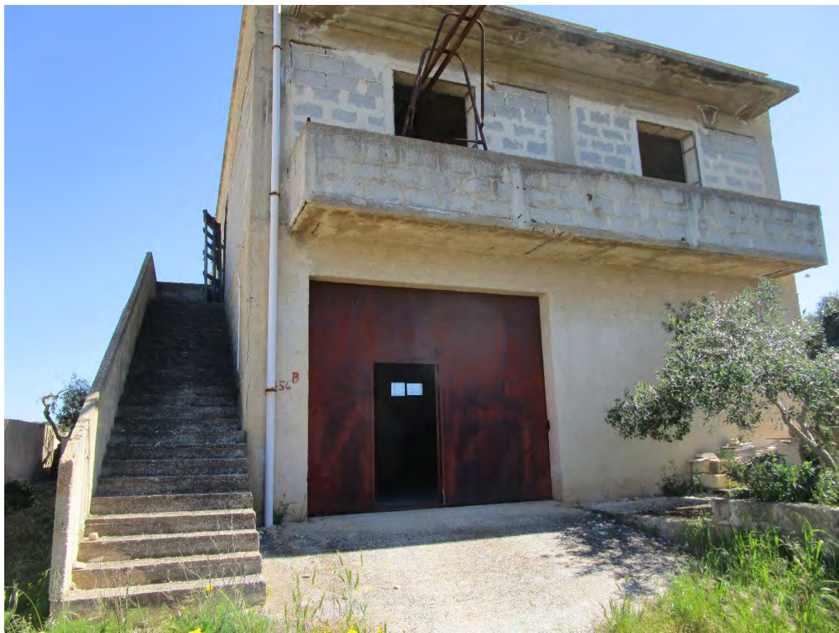
Immobile sito in Marsala c\da Colombaio Lasagna – Vista prospetto sud ingresso magazzino e scala esterna di accesso al piano primo
