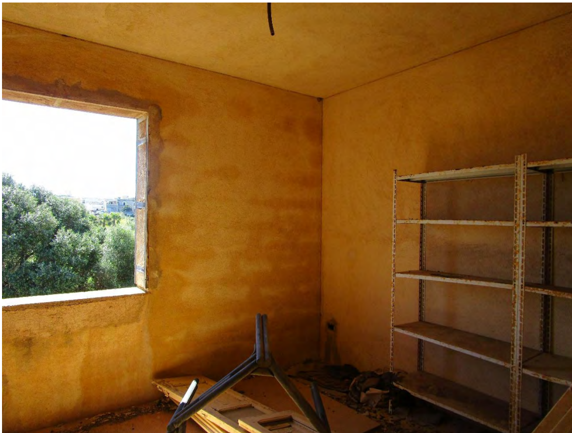
Immobile sito in Marsala c\da Colombaio Lasagna – Vista interna del vano letto sul lato sud-est in corso di costruzione, da notare la realizzazione dei controtelai per gli infissi.
