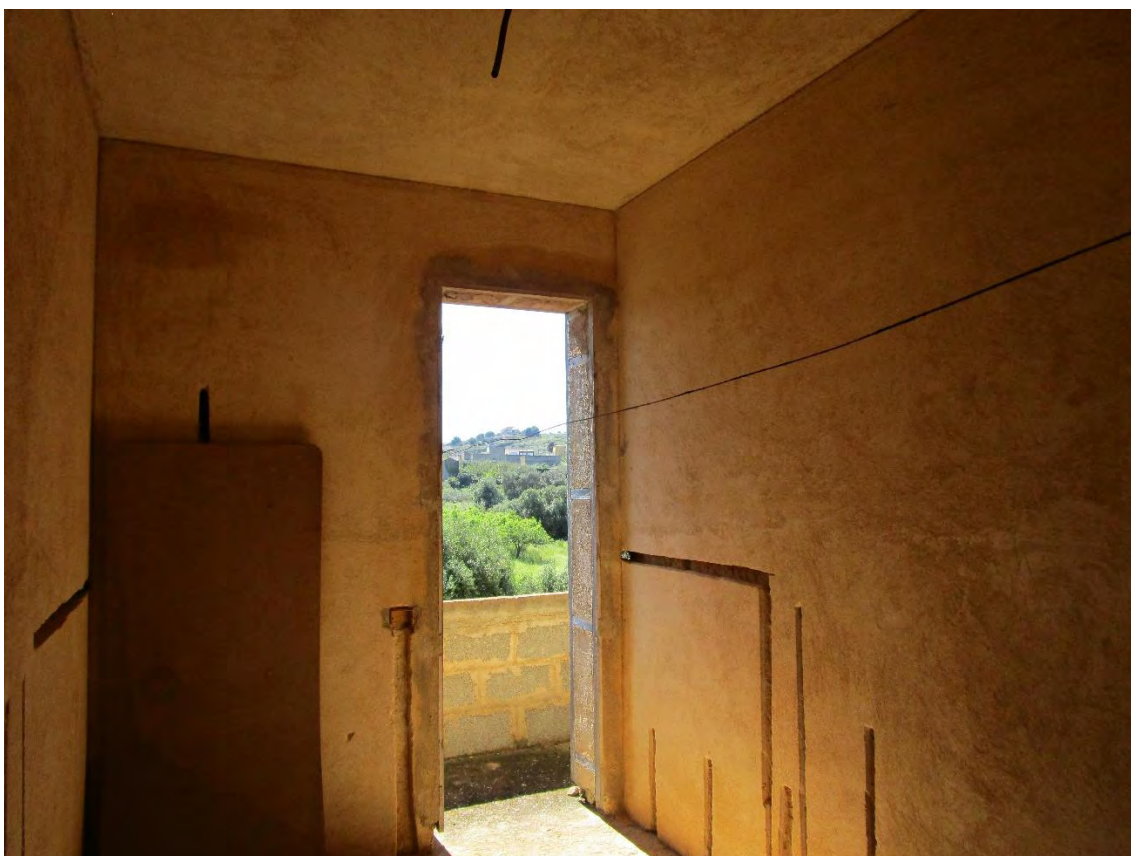
Immobile sito in Marsala c\da Colombaio Lasagna – Vista interna del wc in corso di costruzione, da notare la realizzazione delle tracce per l'impianto idrico.
