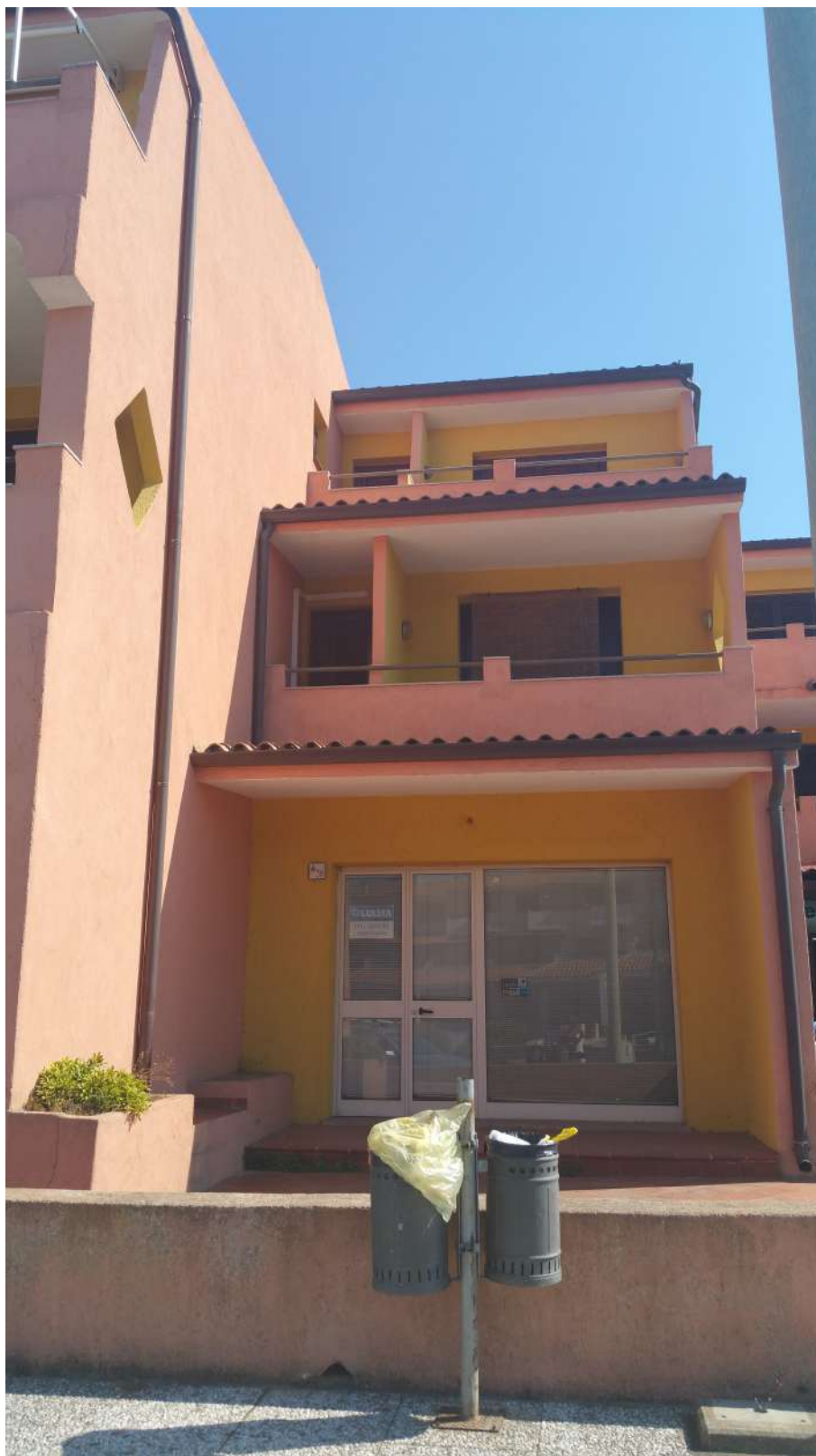
Foto 1 - Prospetto principale su via A. Moro
