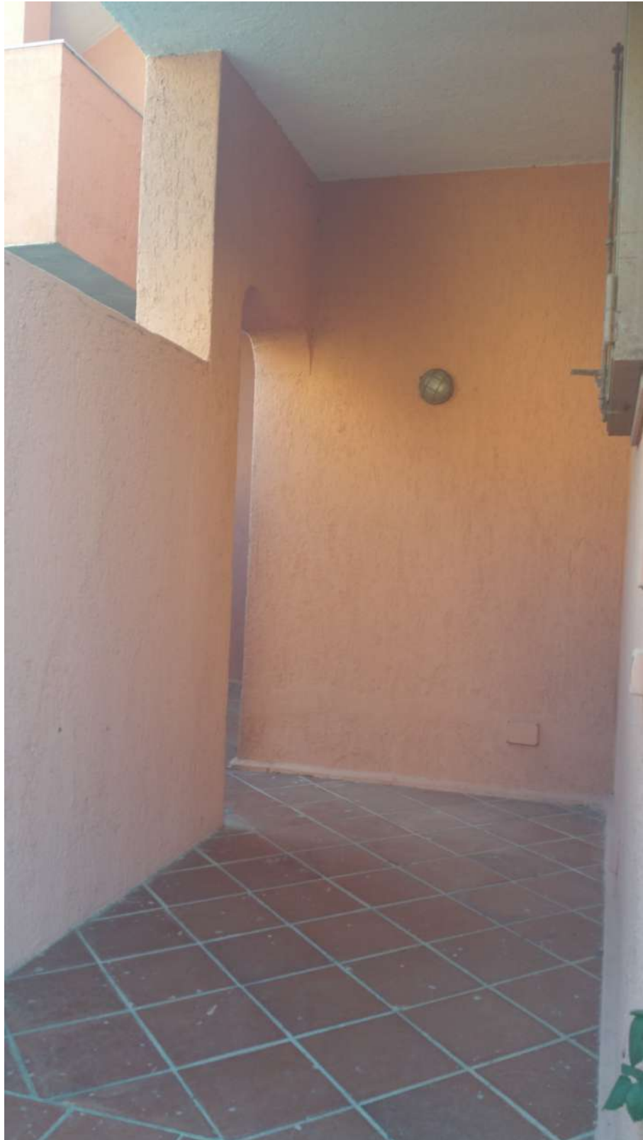
Foto 2 - Ingresso comune agli appartamenti
