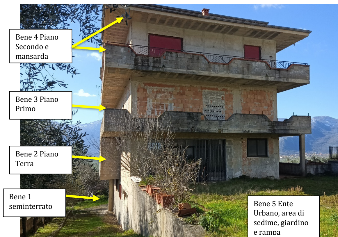
Vista dal cancello di ingresso, sulla strada statale 95.
