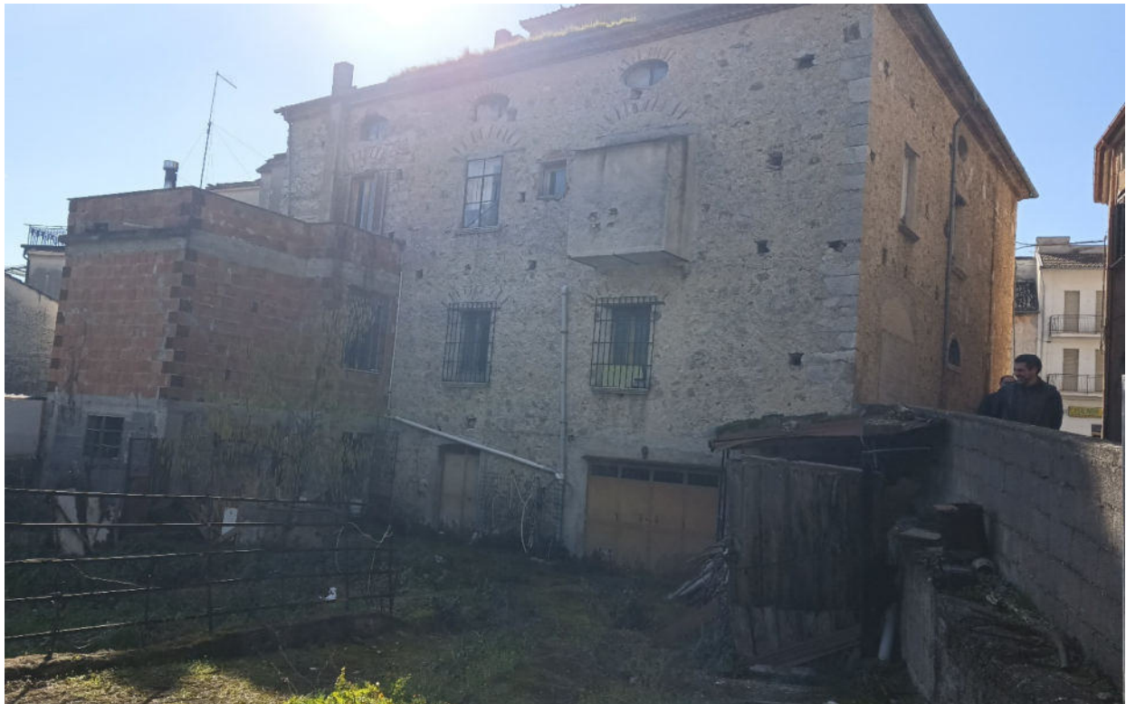
foto n° 4 - Bene 13 vista dal retro, corte
