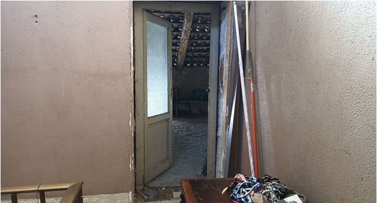
foto n° 17- Bene 13 (piano sottotetto) ingresso dal vano scala
