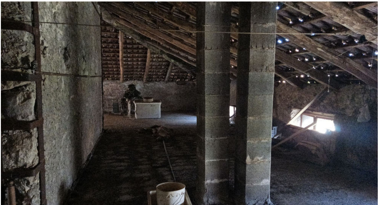
foto n° 20- Bene 13 (piano sottotetto)
