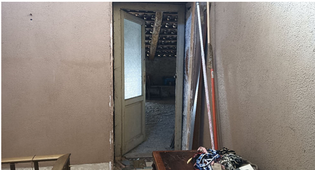
foto n° 17- Bene 13 (piano sottotetto) ingresso dal vano scala
