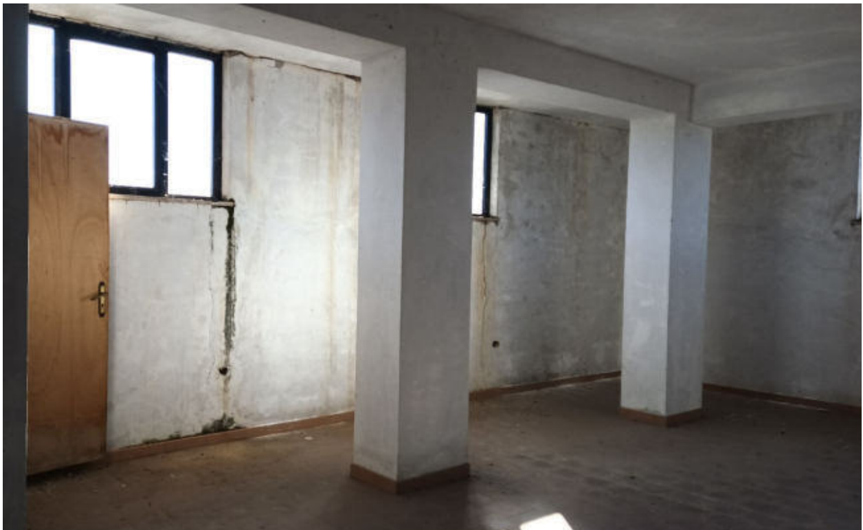
foto n° 11 - Bene 2 vista interna
