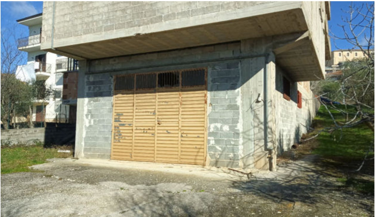
foto n° 5 - accesso al piano seminterrato (Bene 1)
