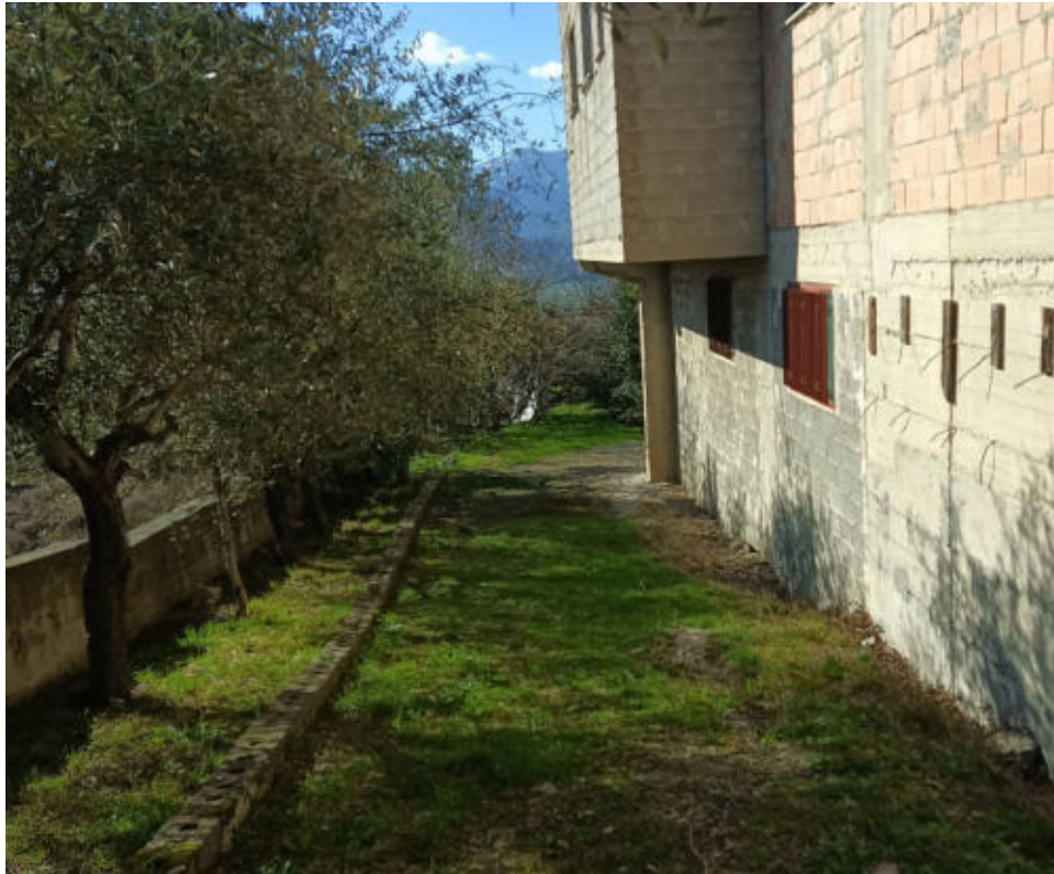
foto n° 3 - accesso al rerro del fabbricato
