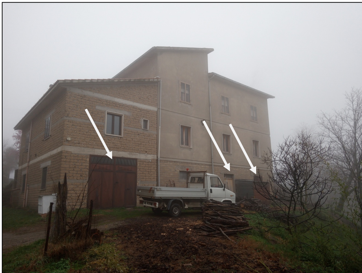
Fig.12: Locale tecnico e cantine
