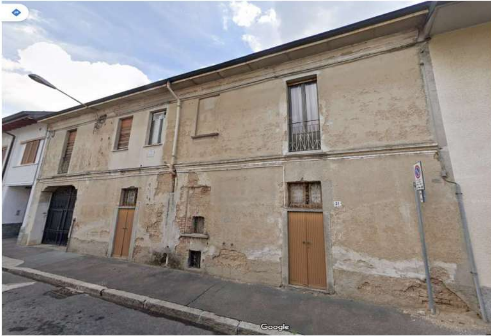
Facciata via Ferrara
