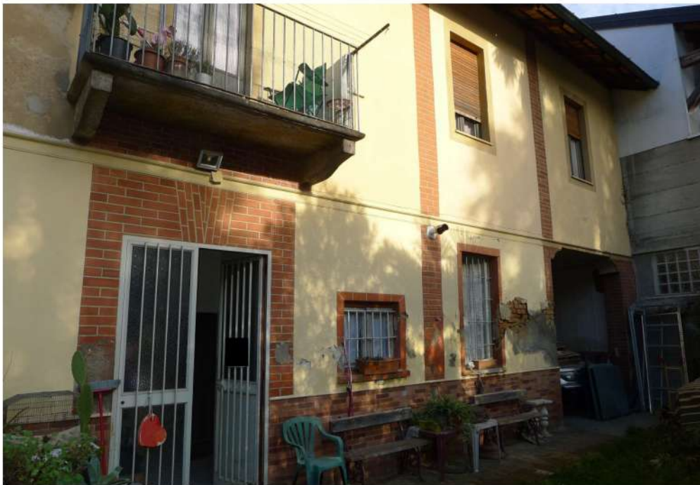
Facciata interna cortile
