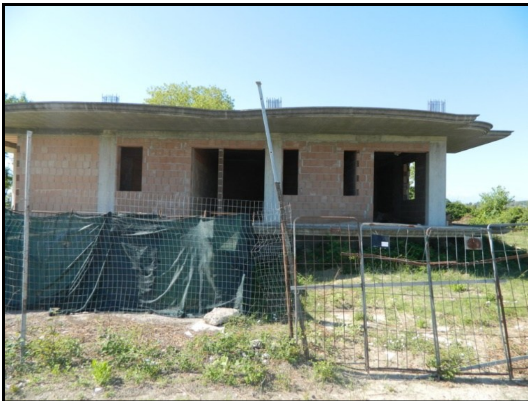
02 – Vista immobile lato Nord
