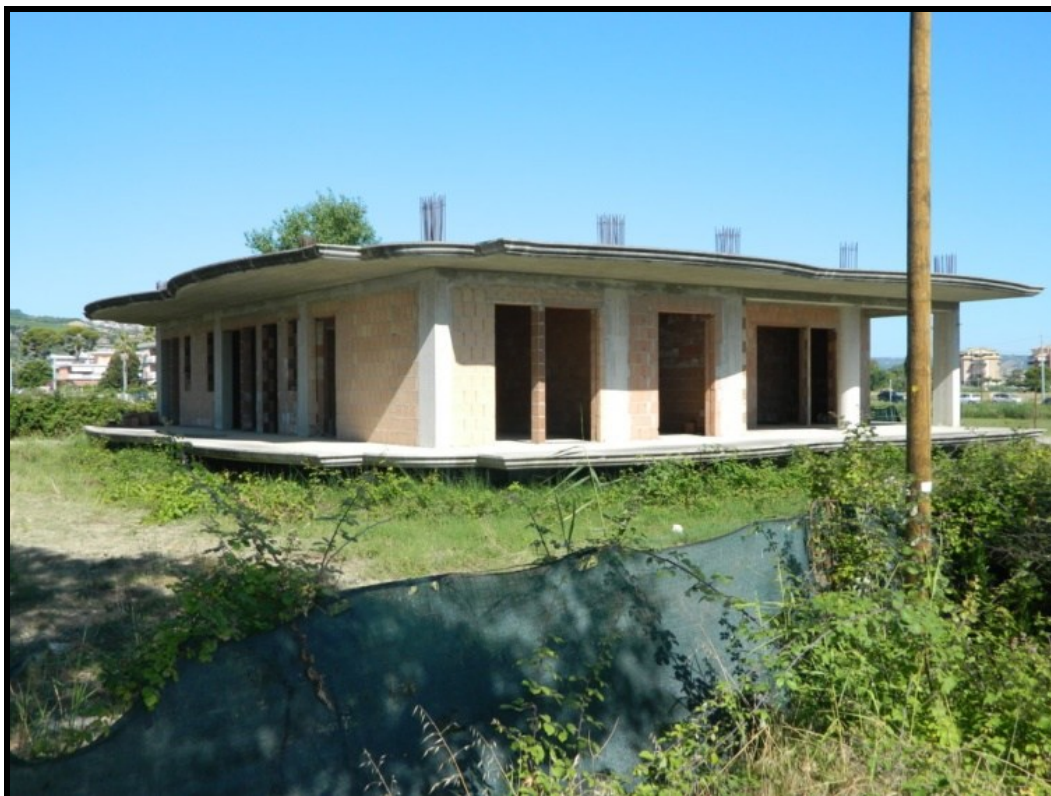
06 – Vista immobile lato Sud
