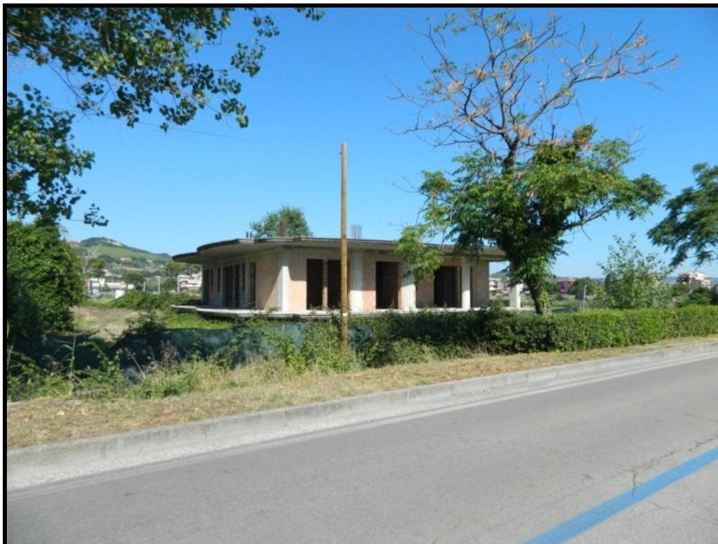
05 – Vista immobile lato Sud-Est
