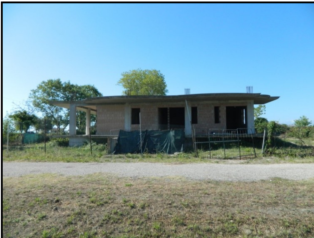
03 – Vista immobile lato Nord
