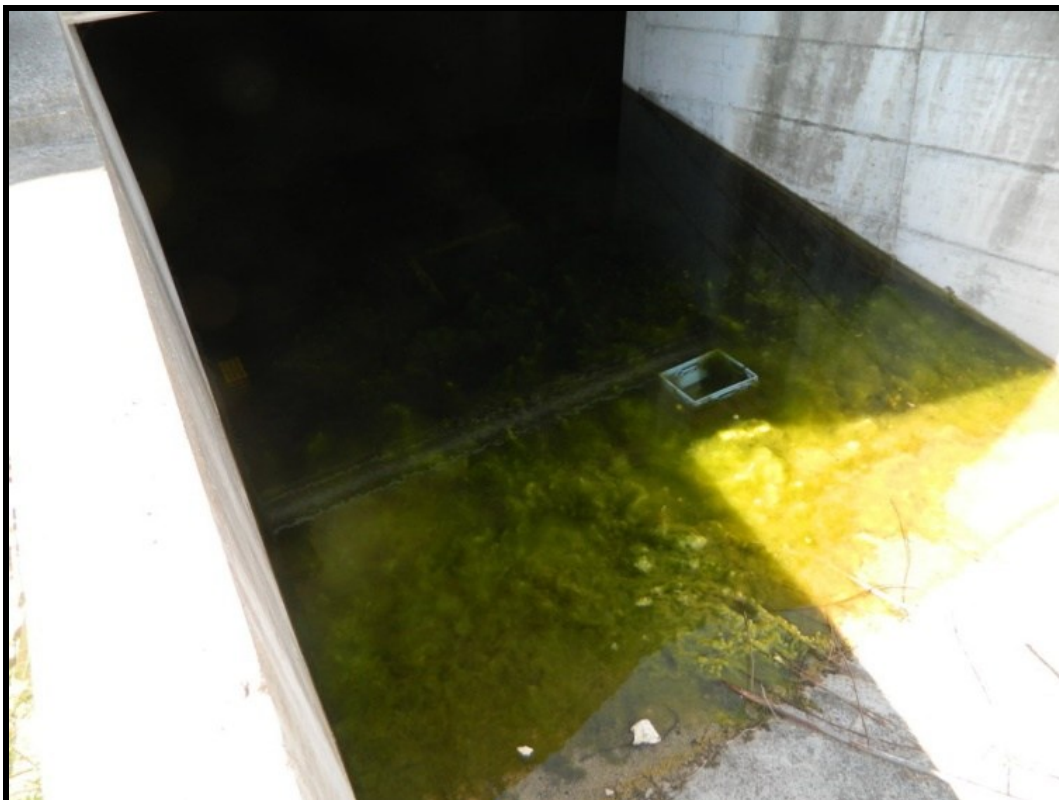
07 – Vista scivolo piano interrato
