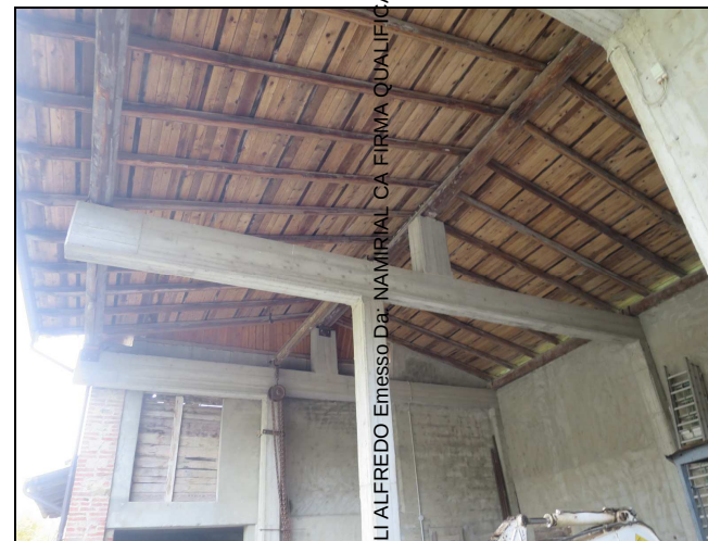
Foto n. 16 - “Fabbricato C” particolare tetto
