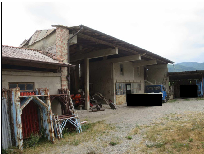
Foto n. 13 – “Fabbricato C” prospetto nord ovest
