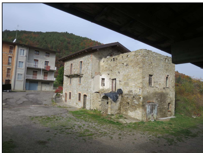
Foto n. 11 – “Fabbricato B” prospetti sud est
