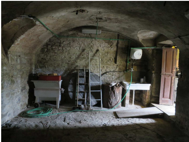
Foto n. 5 – “Fabbricato A” cantina
