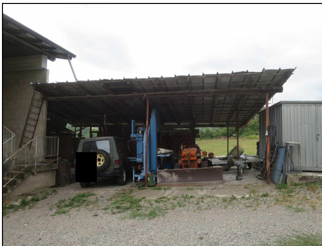
Foto n. 17 – “Fabbricato D” prospetto nord
