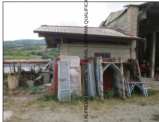
Foto n. 20 - “Fabbricato D” prospetto ovest
