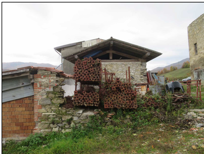
Foto n. 21 – “Fabbricato E” fronte nord
