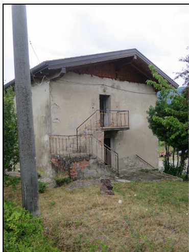
Foto n. 3 - “Fabbricato A” prospetto ovest
