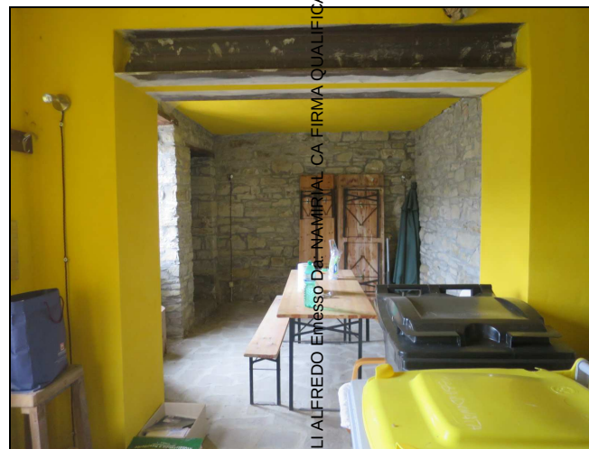
Foto n. 4 – “Fabbricato A” taverna
