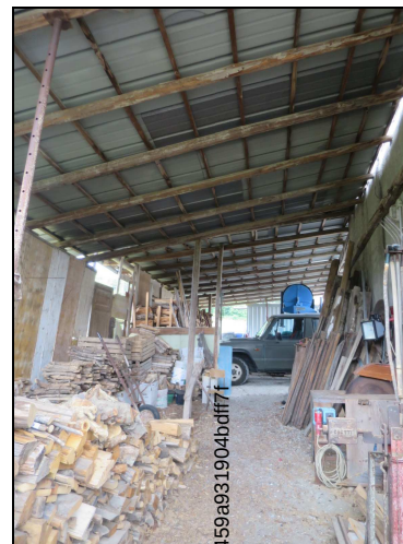
Foto n. 18 - “Fabbricato D” interno est ovest
