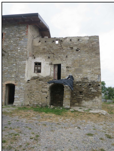
Foto n. 9 – “Fabbricato B” prospetto sud
