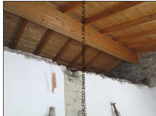
Foto n. 8 - “Fabbricato A” interno P.2°
