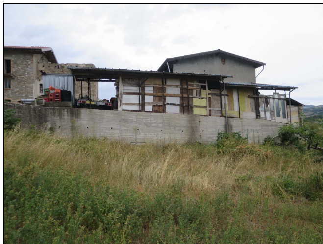
Foto n. 19 – “Fabbricato D” prospetto sud
