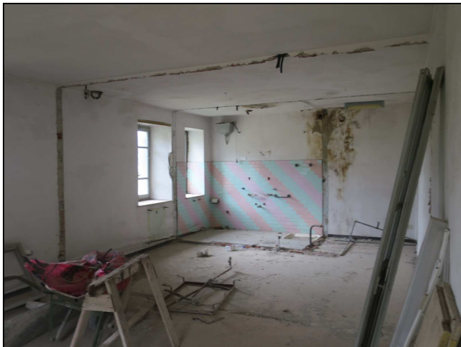
Foto n. 7 – “Fabbricato A” interno P.2°
