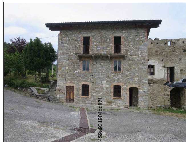
Foto n. 2 - “Fabbricato A”, prospetto sud
