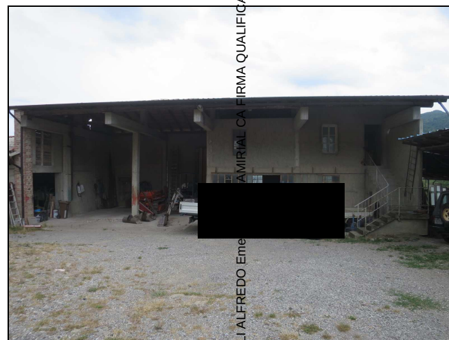
Foto n. 12 - “Fabbricato C” prospetto ovest
