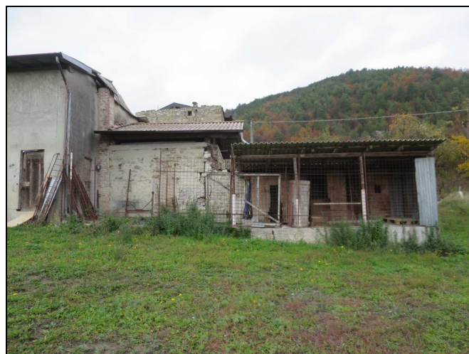
Foto n. 23 – “Fabbricato F” prospetto est
