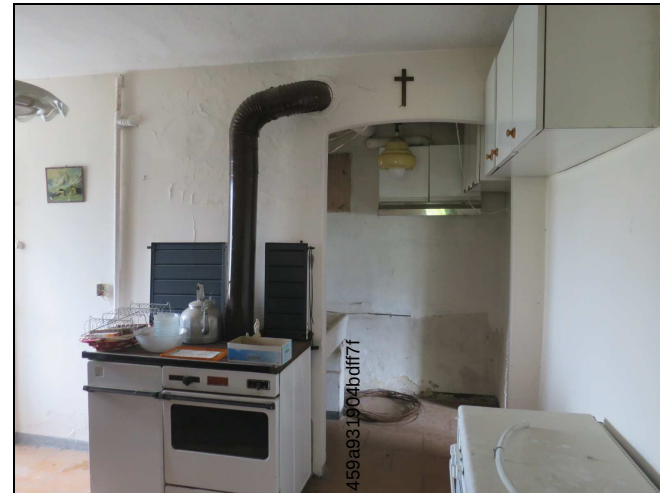
Foto n. 6 - “Fabbricato A” interno P.1°
