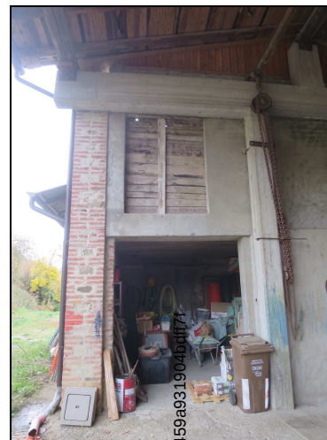
Foto n. 22 - “Fabbricato E” ingresso sud
