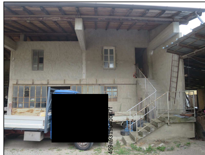
Foto n. 14 - “Fabbricato C” particolare prospetto ovest
