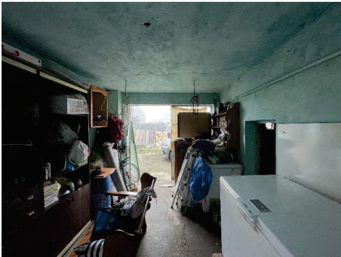
53. Box, vista interna.
