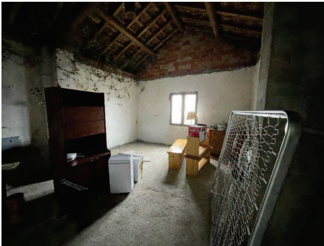
35. Locale sgombero al piano intermedio.
