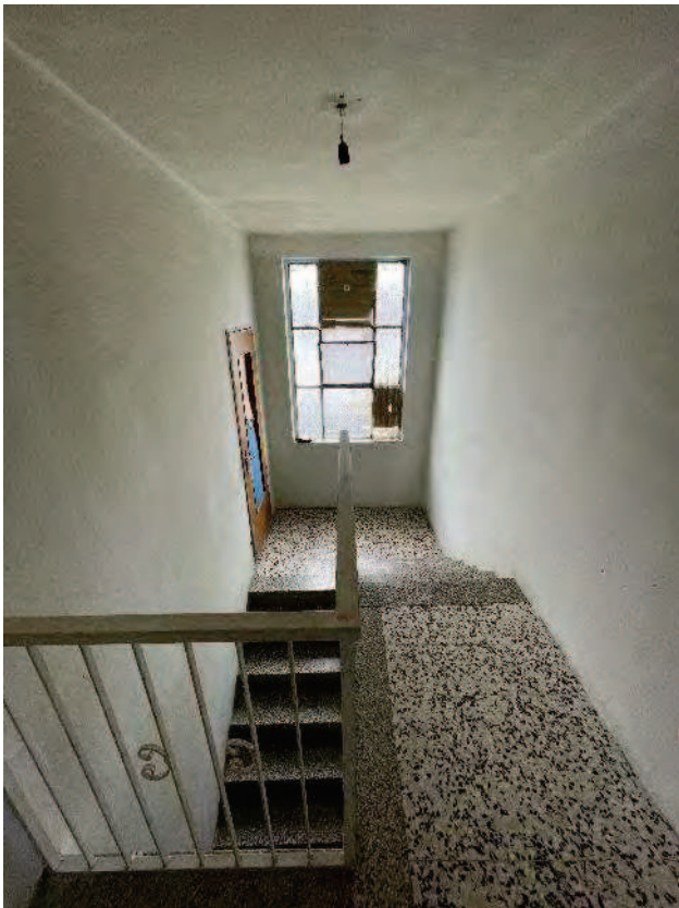
37. Vano scala con accesso al locale sgombero.
