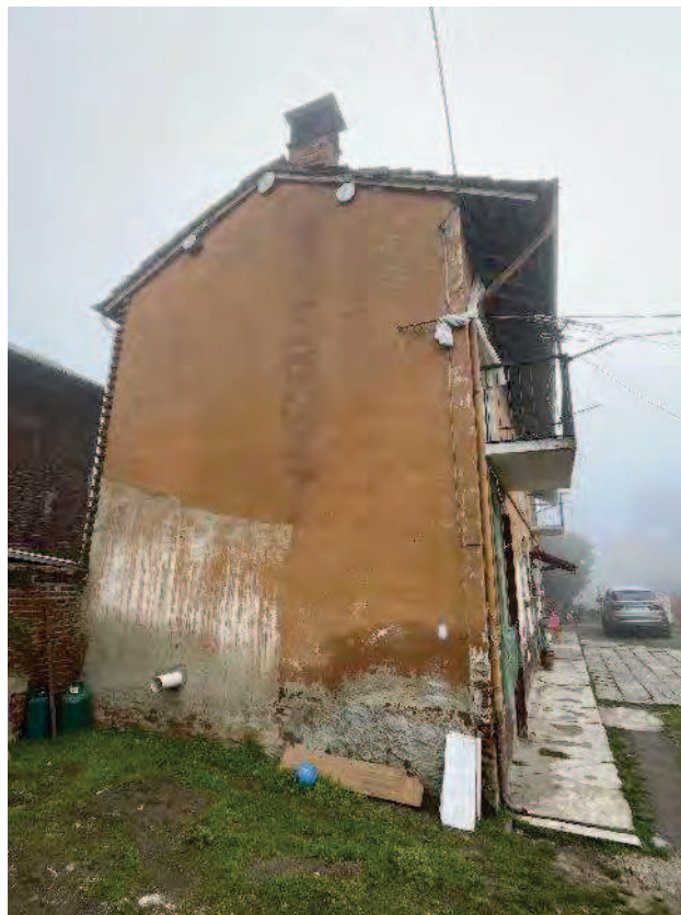
7. Fabbricato oggetto di E.I., vista lato nord-ovest.
