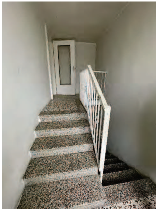
34. Vano scala con sbarco al P.1.
