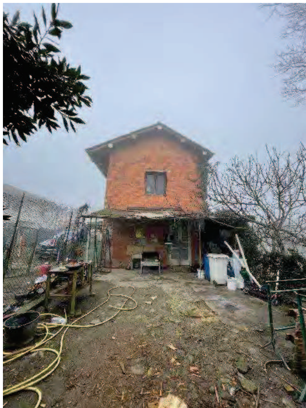
6. Fabbricato oggetto di E.I., vista lato sud-est.
