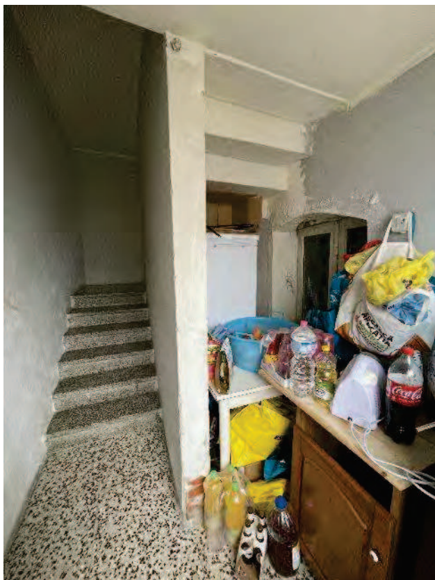
31. Vano scala a P.T.
