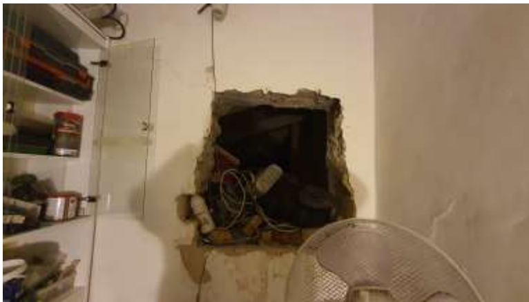
PASSAGGIO VERSO SOTTOTETTO
