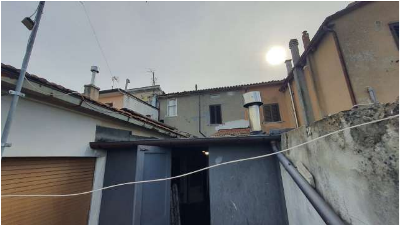
TETTOIA SU TERRAZZO
