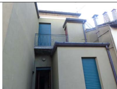
Facciata interna vista da terrazzo p1
