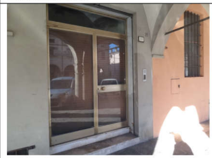
Ingresso da porticato uso pubblico fronte strada
