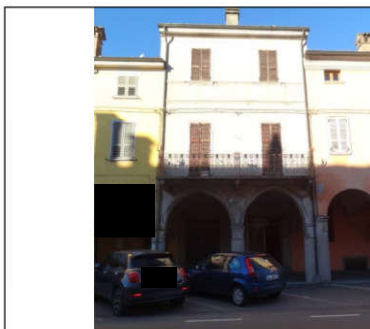
Vista da strada
