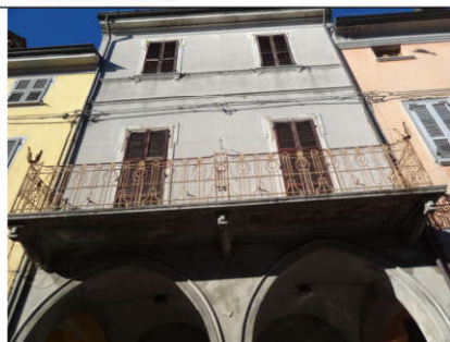
Facciata fabbricato su via Cavour
