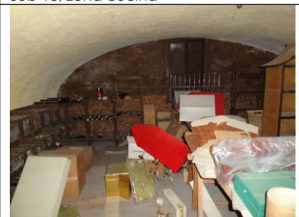
Sub 15, zona cantina
